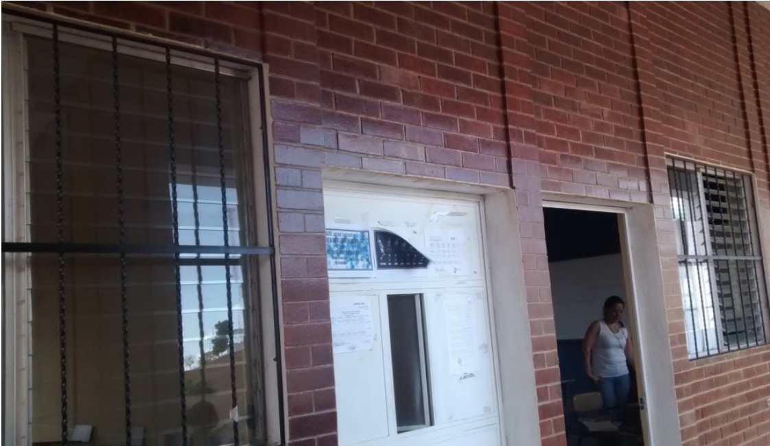
(Salones de la carrera de Administración de Empresas sin rotulación.)
