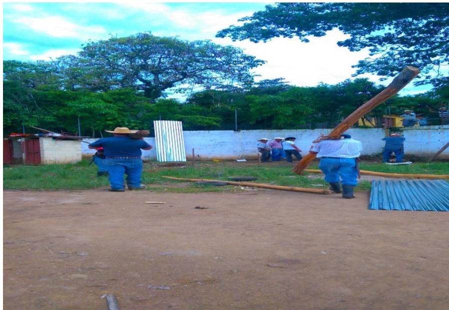
Fig.18. Acarreando material para la construcción provisional. EPS, -CUNSARO- Lisby Hernández
