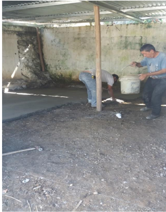
Fig. 53. Entortando la Oficina Provisional. EPS, -CUNSARO- Lisby Hernández
