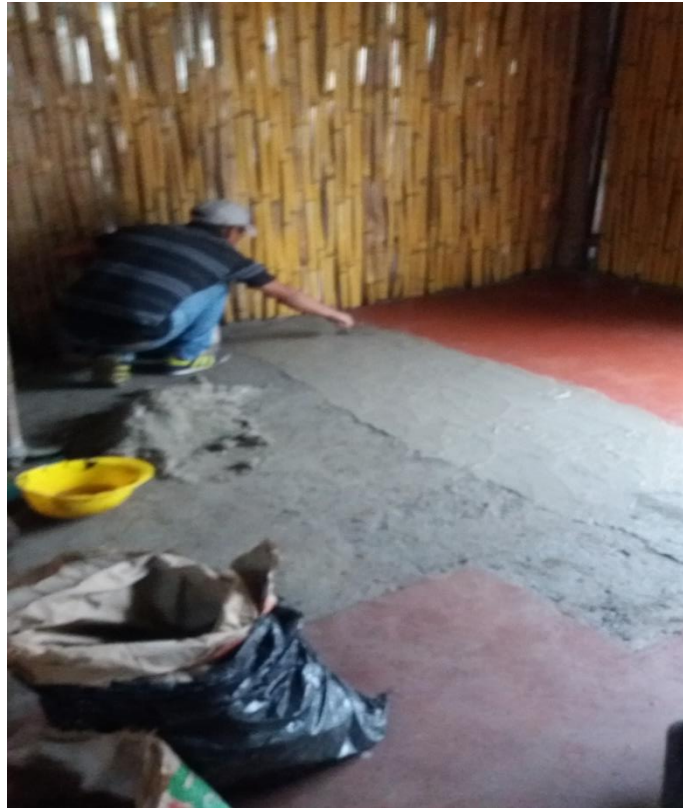
Fig. 22. Colaborador trabajando el entortado de la Oficina Provisional. EPS, -CUNSARO-Lisby Hernández
