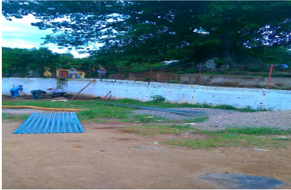
Fig. 19. Material para la construcción provisional. EPS, -CUNSARO- Lisby Hernández
