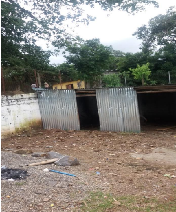
Fig. 21. Levantamiento de la Oficina Provisional. EPS, -CUNSARO- Lisby Hernández
