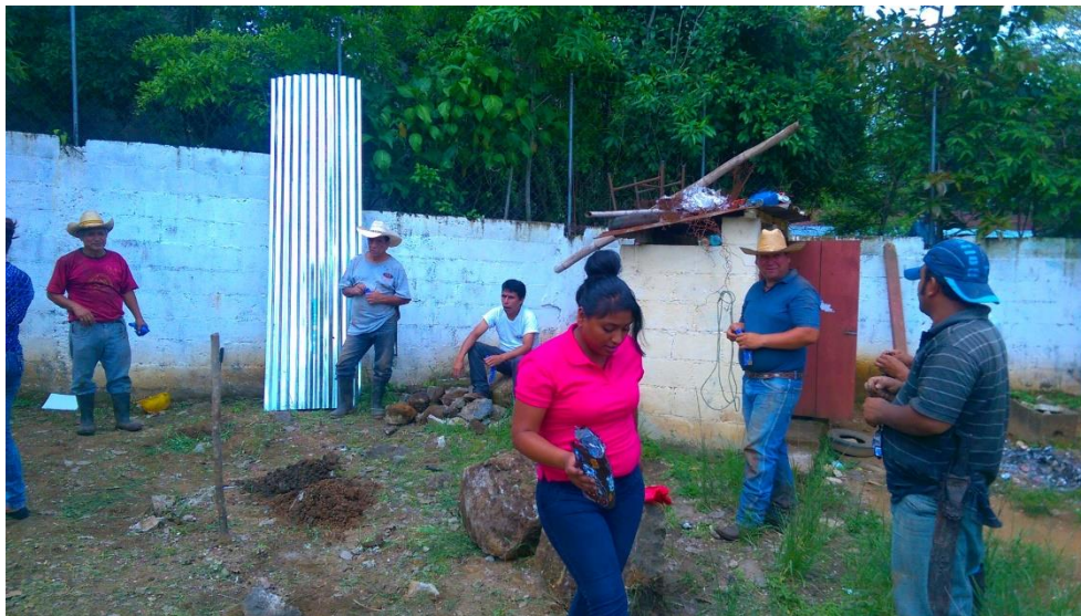
Fig. 20. Trabajando para la construcción provisional. EPS, -CUNSARO- Lisby Hernández
