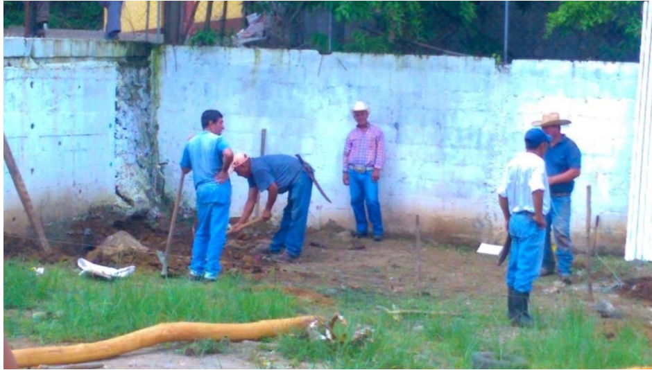
Fig. 17. Iniciando la construcción de la Oficina Provisional. EPS, -CUNSARO- Lisby Hernández
