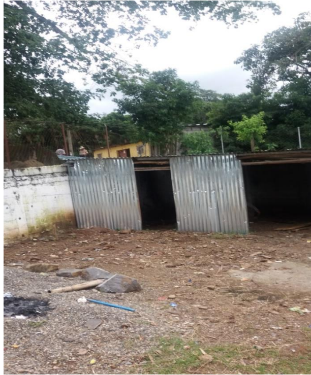
Fig. 17. Levantamiento de la Oficina Provisional. EPS, -CUNSARO- Silma López
