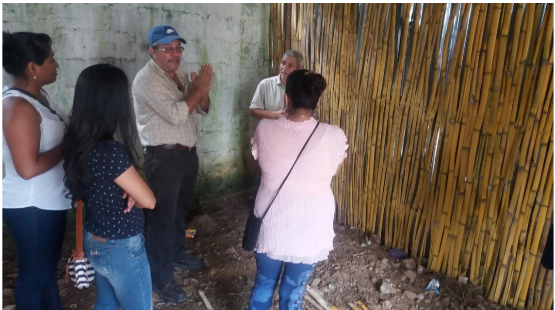
Fig. 47 Verificando la construcción provisional. EPS,-CUNSARO-Silma López
