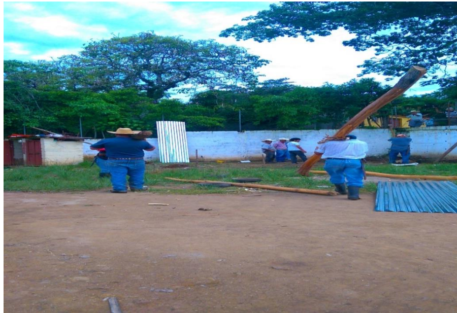
Fig.14. Acarreando material para la construcción provisional. EPS, -CUNSARO- Silma López
