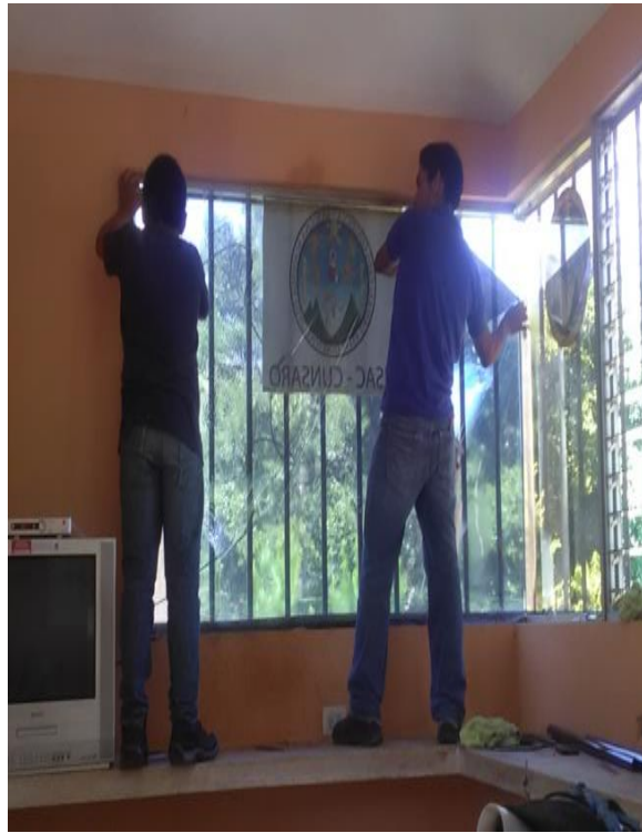
Foto No. 46/Colocación de polarizado/ Irma Divas/EPS -CUNSARO-
