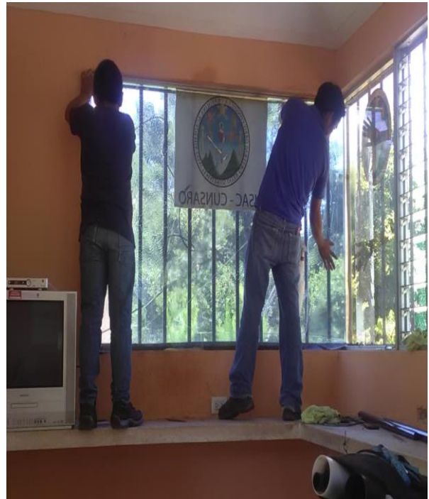
Foto No. 21/Colocación de polarizado/Irma Divas/EPS -CUNSARO-
