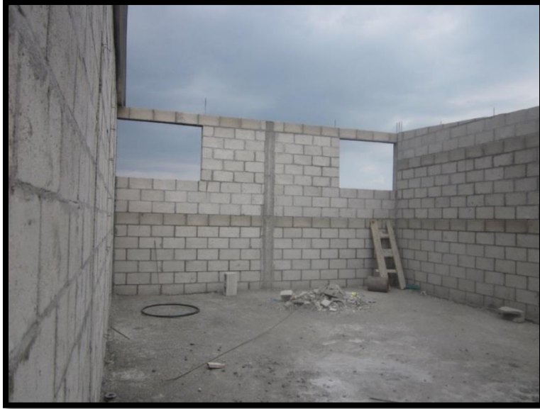
Fotografía número 19: Después, levantamiento de paredes en salón de clases.
