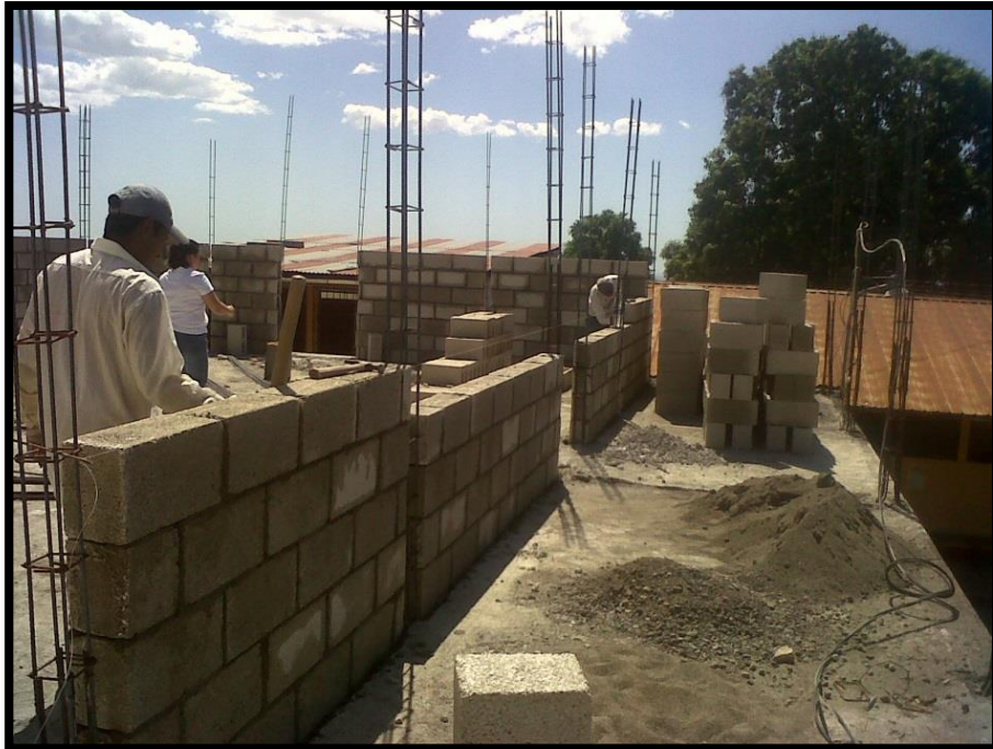
Fotografía número 15: Durante, levantamiento de paredes frontales
