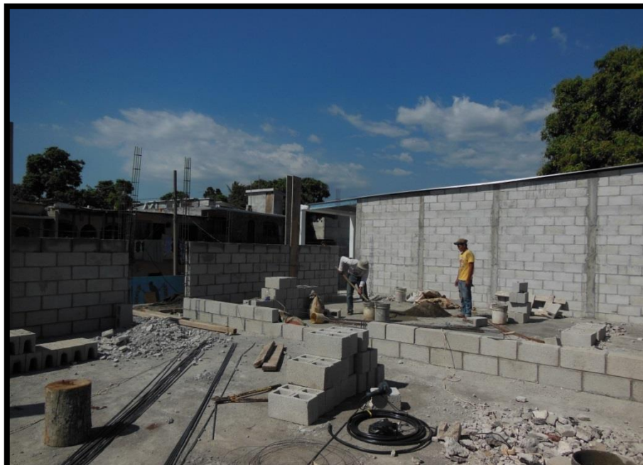
Fotografía número 14: Durante, levantamiento de paredes laterales
