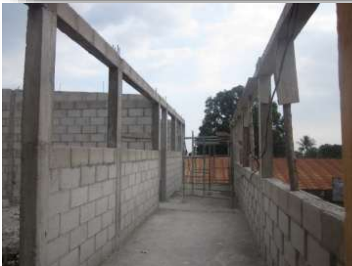
Fotografía No. 9 Después de la construcción de los salones de clases
