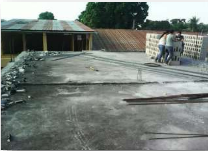
Fotografía No. 7 Antes de la construcción de los salones de clases
