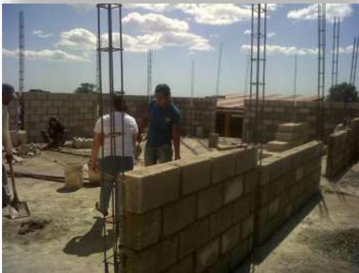
Fotografía No. 8 Durante la construcción de los salones de clases
