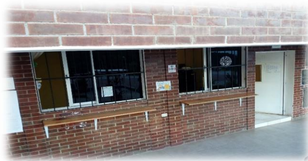
Fuente: Edición Propia (Fotografía No 25) Fecha: Julio 2016 Ejecución del Proyecto
