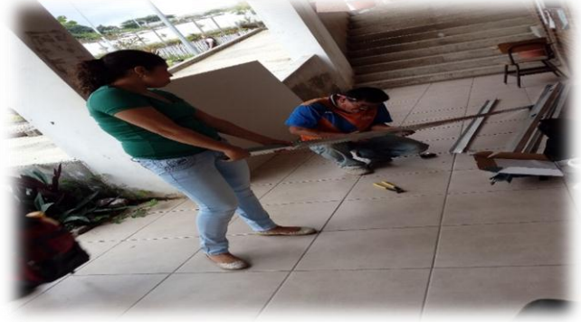
Fuente: Edición Propia (Fotografía No 17) Fecha: Julio 2016 Ejecución del Proyecto
