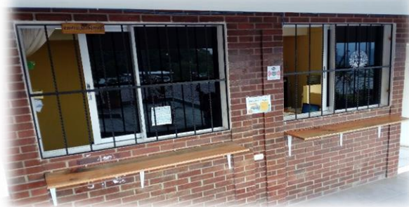
Fuente: Edición Propia (Fotografía No 24) Fecha: Julio 2016 Ejecución del Proyecto
