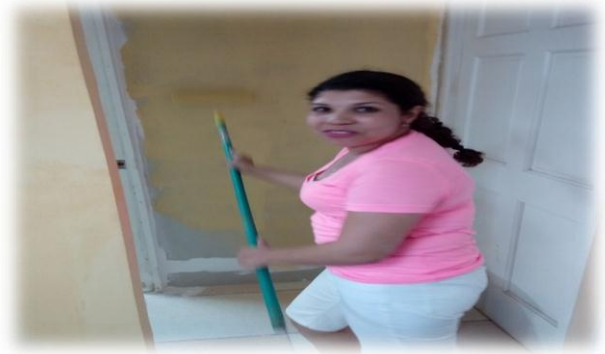
Fuente: Edición Propia (Fotografía No 19) Fecha: Julio 2016 Ejecución del Proyecto
