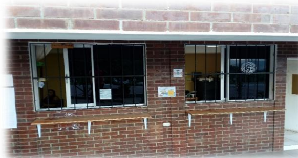
Fuente: Edición Propia (Fotografía No 26) Fecha: Julio 2016 Ejecución del Proyecto
