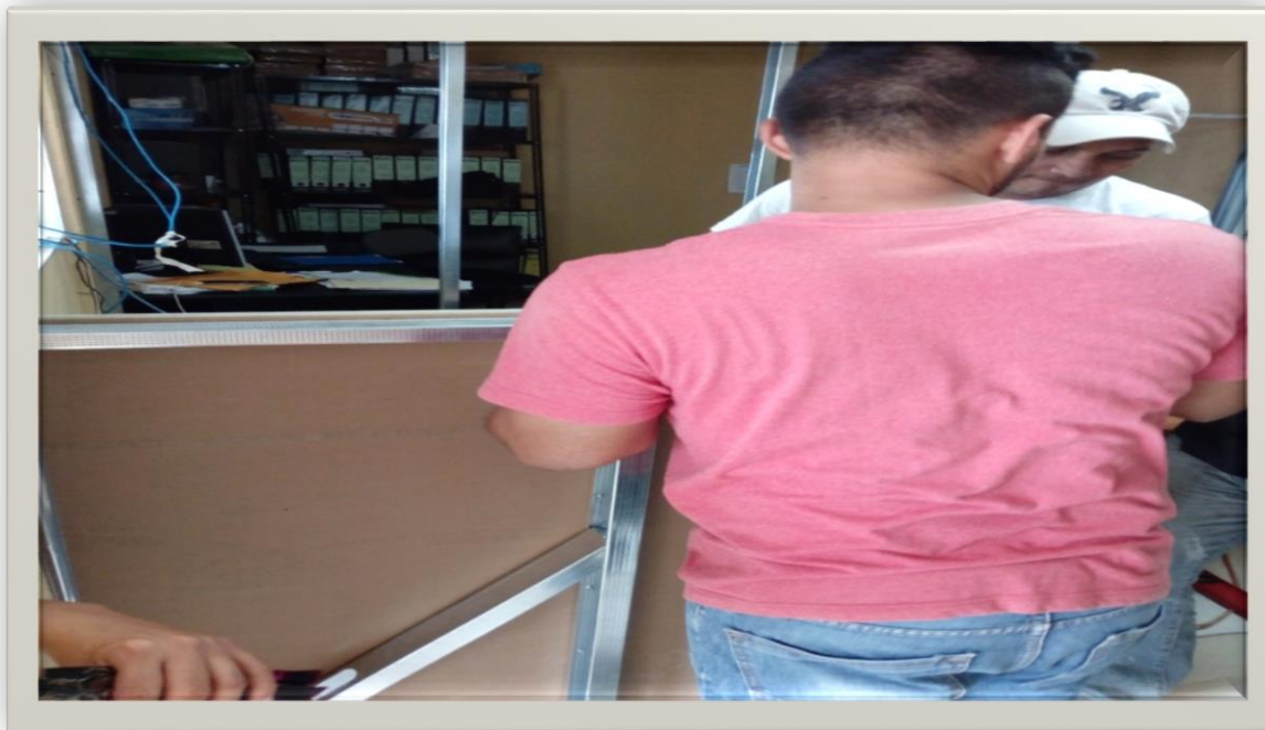
Fuente: Edición propia (Fotografía No 17) Fecha: julio 2016 Ejecución del proyecto
