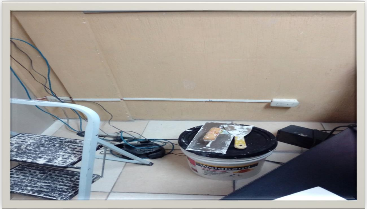
Fuente: Edición propia (Fotografía No 23) Fecha: julio 2016 Ejecución del proyecto
