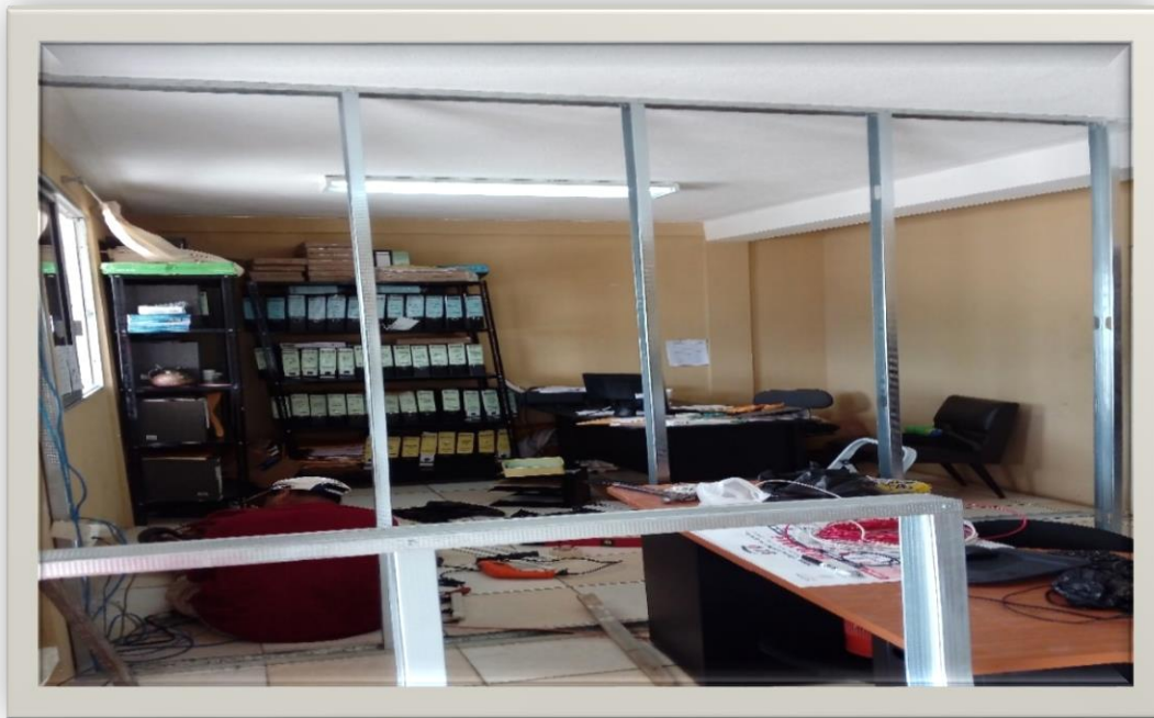
Fuente: Edición propia (Fotografía No 21) Fecha: julio 2016 Ejecución del proyecto
