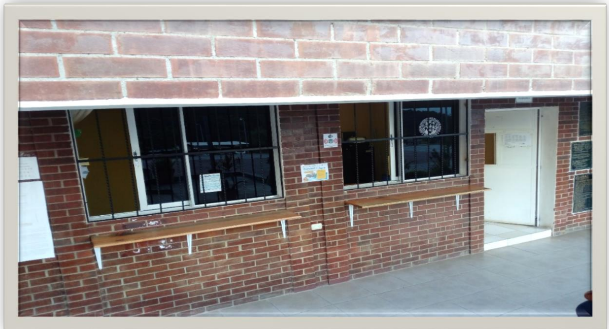
Fuente: Edición propia (Fotografía No 26) Fecha: julio 2016 Ejecución del proyecto
