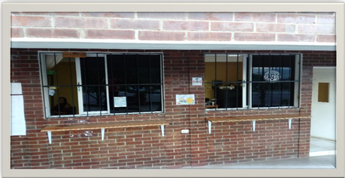
Fuente: Edición propia (Fotografía No 27) Fecha: julio 2016 Ejecución del proyecto
