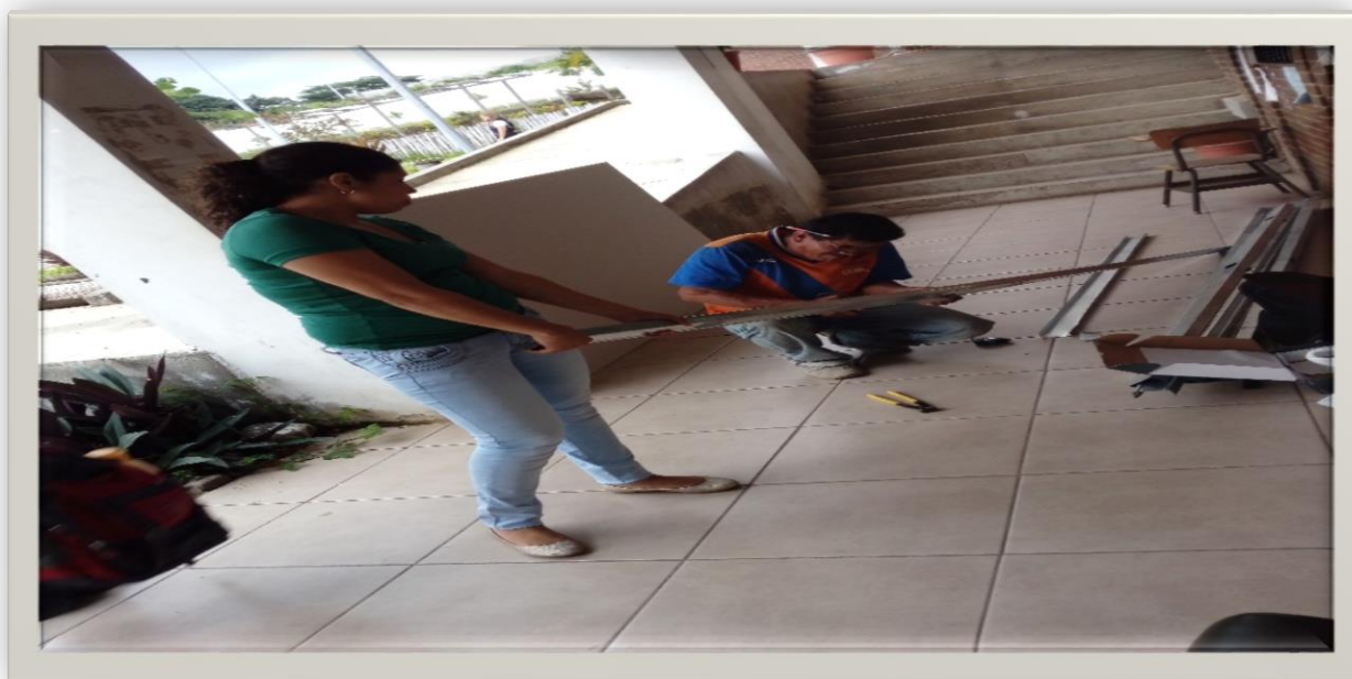
Fuente: Edición propia (Fotografía No 18) Fecha: julio 2016 Ejecución del proyecto
