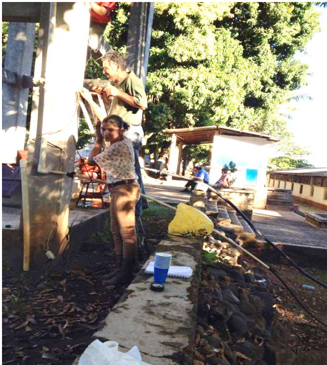
Estas imágenes muestran los diferentes momentos en que se realizan los pasos para la instalación de tubos PVC para mejorar el fluido del agua potable a los diferentes servicios de las instalaciones de la Escuela Tipo Federación Juan José Arévalo Bermejo de Taxisco, Santa Rosa.
