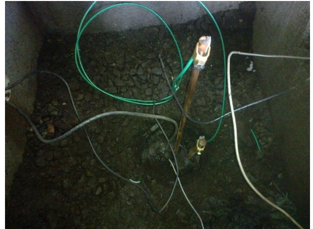
Fotografía # 22 tomada al proyecto ejecutado en el Centro Universitario de Santa Rosa
