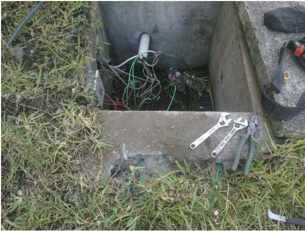
Fotografía # 21 tomada al proyecto ejecutado en el Centro Universitario de Santa Rosa
