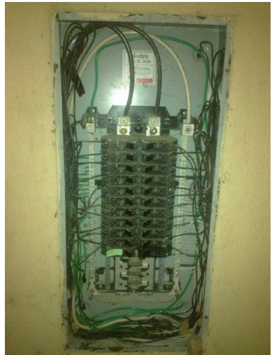
Fotografía # 24 tomada al proyecto ejecutado en el Centro Universitario de Santa Rosa
