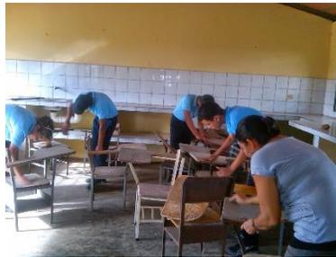
*Ilustración 32. Lijado de piezas de madera para volver a pintar.*
