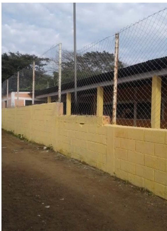
Foto 13 Muro perimetral después
