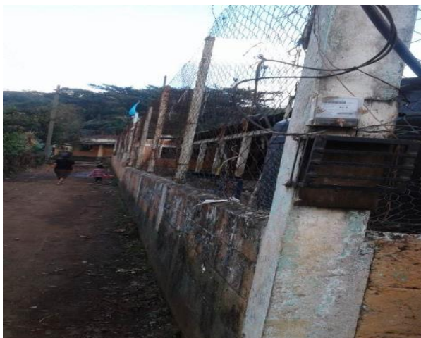
Foto 9 Muro perimetral antes
