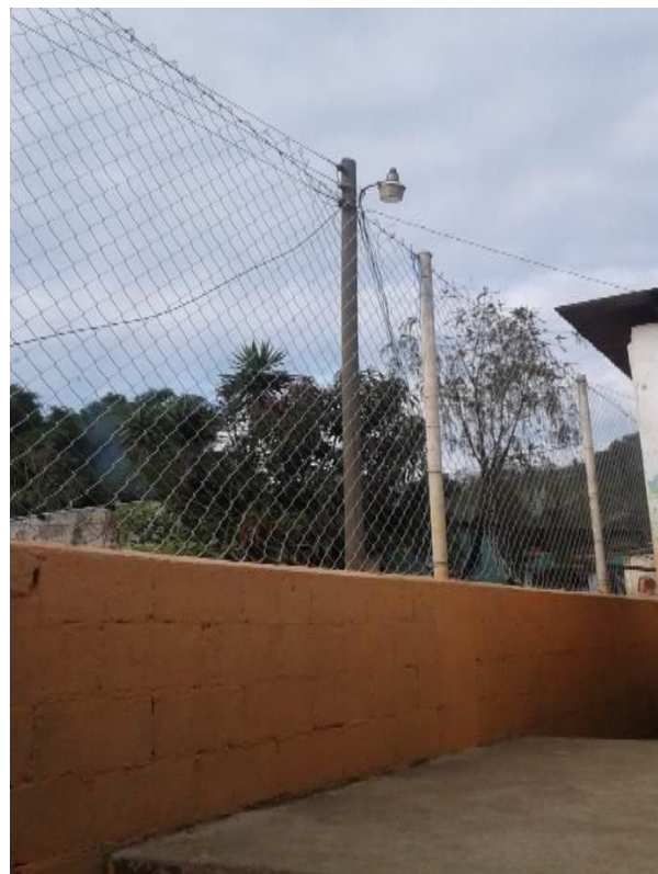
Foto 14 Muro perimetral después
