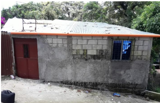
Foto No. 6/Exterior de la sede de la biblioteca comunitaria
