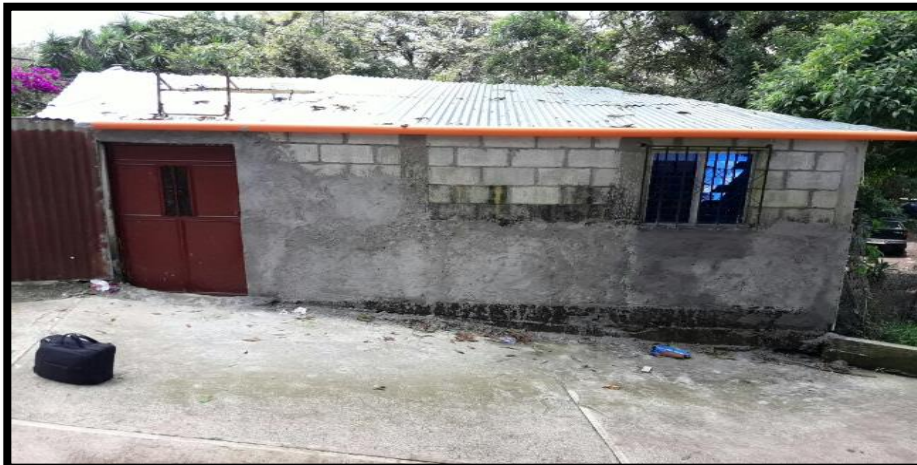
Foto No.06/parte exterior del local a futuro para el uso de la biblioteca.
