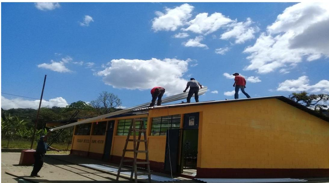
Foto 7 estructura del nuevo techo en reparación
