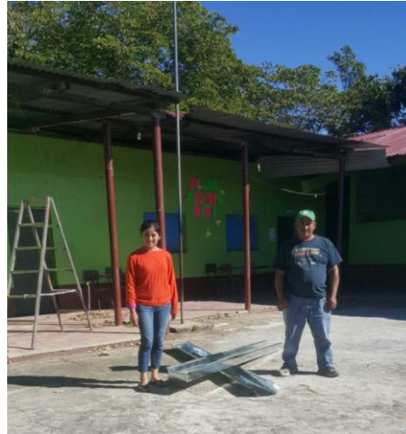
Figura 11: durante la instalación de canales
