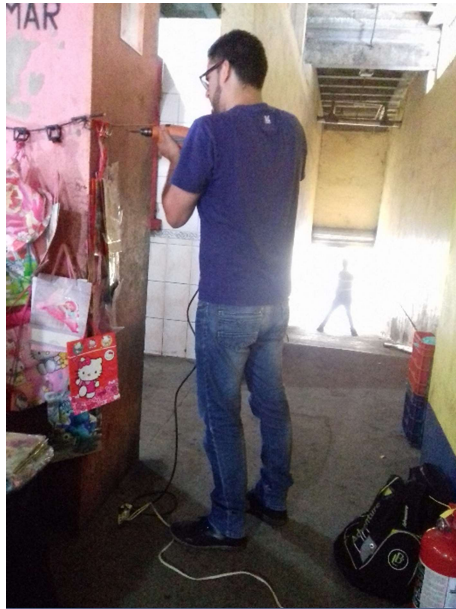
Figura No. 22 Instalación del extintor en el primer nivel del mercado municipal. Fuente: Fotografía del personal de la municipalidad.
