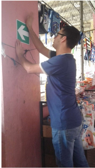
Figura No. 8 Instalación de señales de evacuación dentro del edificio del mercado municipal. Fuente: Fotografía tomada por el personal de la municipalidad.
