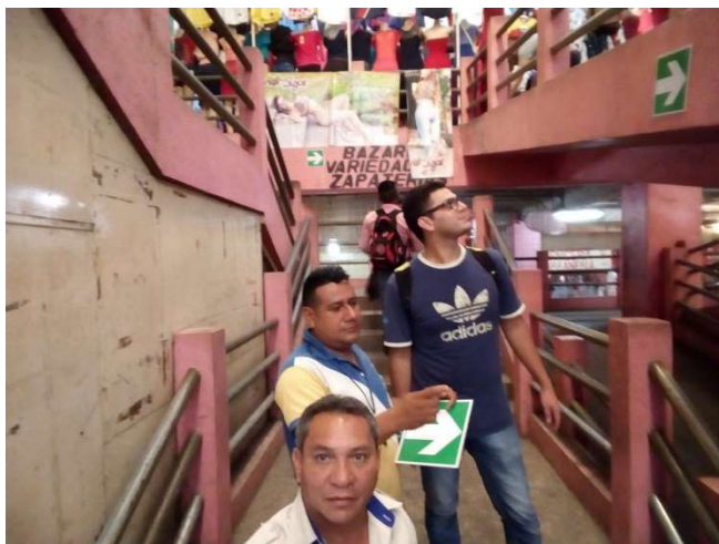
Figura No. 10 Instalación de señal en la rampa dentro del edificio del mercado municipal. Fuente: Fotografía tomada por el delegado departamental de CONRED Santa Rosa.
