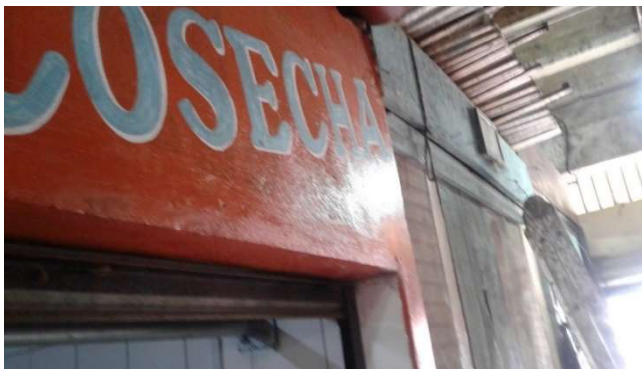
Figura No. 4 Pasillo dentro del mercado municipal. Fuente: Fotografía tomada por el estudiante
