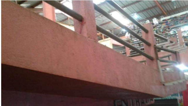
Figura No. 3 Rampa dentro del edificio del mercado municipal. Fuente: Fotografía tomada por el estudiante
