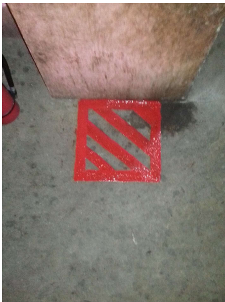
Figura No. 27 Señal pintada en el suelo de la ubicación del extintor en el primer nivel del mercado municipal. Fuente: Fotografía del estudiante.
