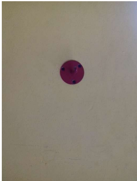
Figura No. 25 Instalación del sujetador del extintor en la municipalidad de Cuilapa, Santa Rosa. Fuente: Fotografía del estudiante.
