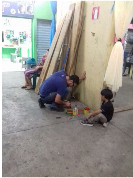
Figura No. 24 Pintando la señal del suelo para extintor en el segundo nivel del mercado municipal. Fuente: Fotografía del personal de la municipalidad.
