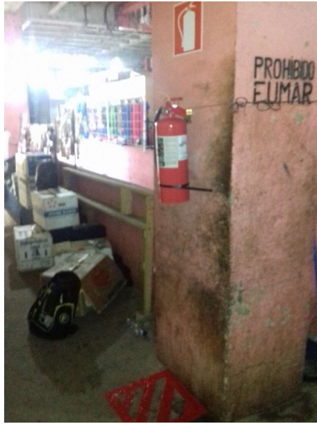
Figura No. 28 Extintor en punto estratégico en el primer nivel del mercado municipal. Fuente: Fotografía del estudiante.
