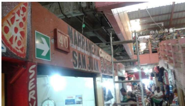
Figura No. 13 Señal instalada dentro del primer nivel del edificio del mercado municipal. Fuente: Fotografía tomada por el estudiante.
