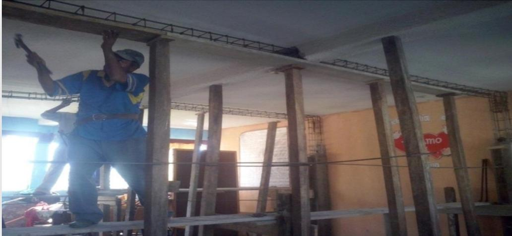
*Figura 10.* La fotografía muestra el reforzamiento de terraza del primer nivel del edificio del instituto IMEDCO.
