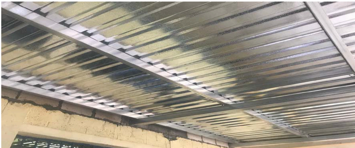
Figura No. 7 Se observa el cambio de techo, con estructura metálica en lugar de madera y lámina nueva. Fuente: elaboración propia.
