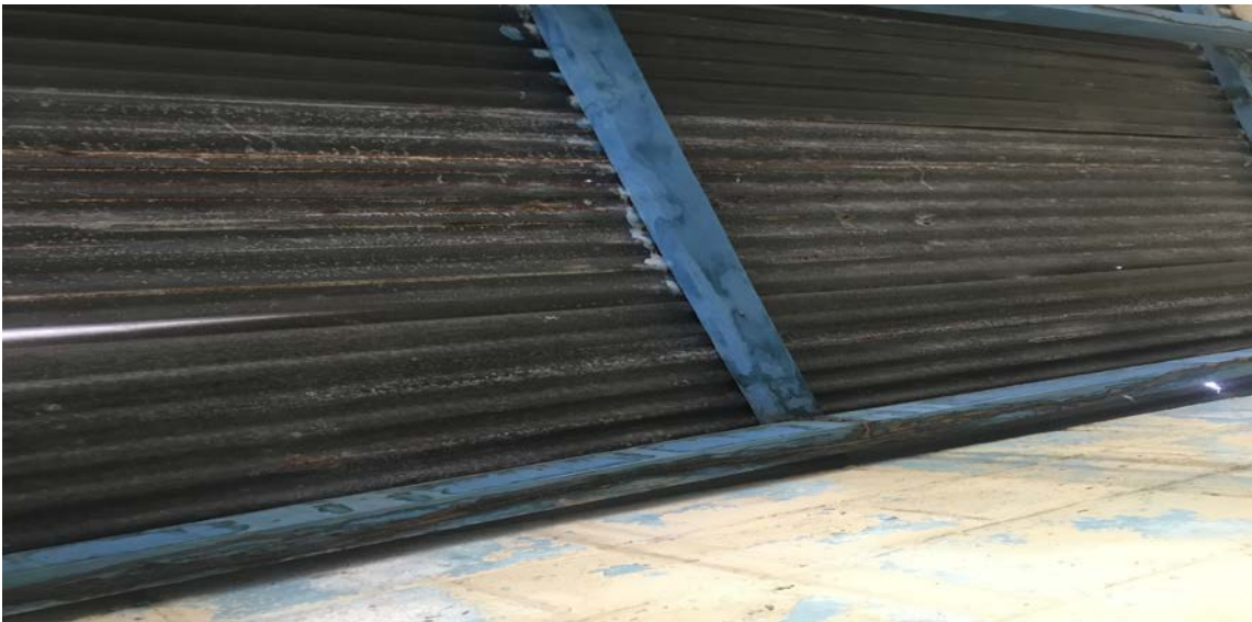
Figura: No.4 Fotografía de la madera picada del techo, con peligro a desplomarse sobre los estudiantes y que permite la filtración de agua. Fuente: elaboración propia.
