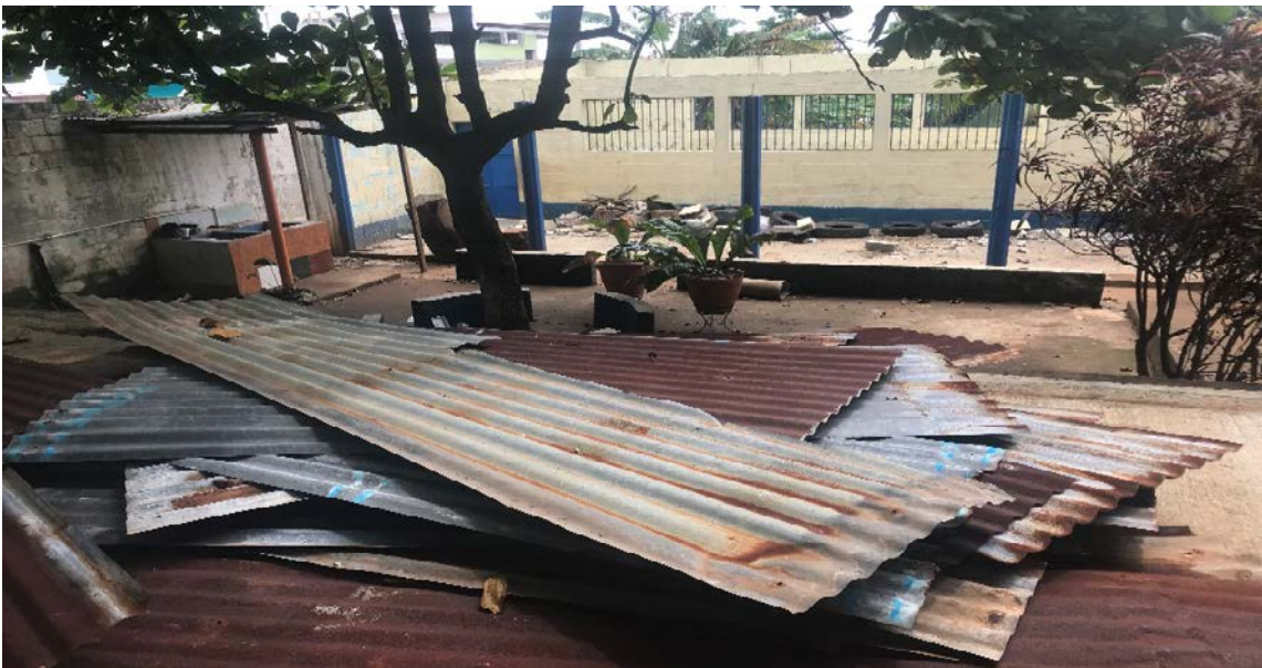
Figura No. 6 Fotografía durante la ejecución del proyecto, se observa la lámina picada que tenía el techo del aula de sexto grado sección "C" Fuente: elaboración propia.
