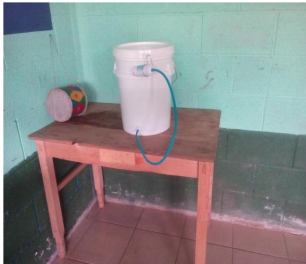
Figura 19/ Evidencia del filtro de agua dentro de las instalaciones de la escuela
