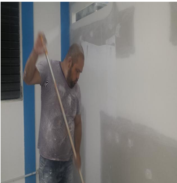
Imagen No. 3 Pintando las paredes que se colocaron.
