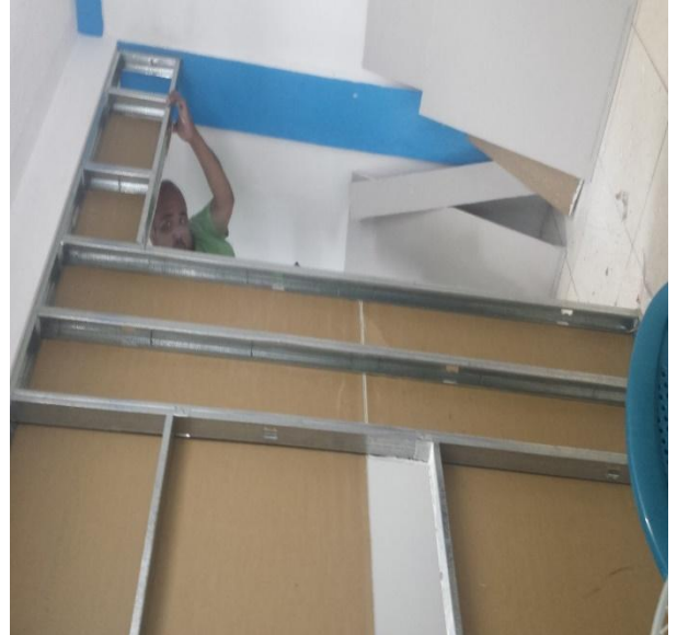
Imagen No. 2 Colocación de parales y planchas de tabla yeso.
