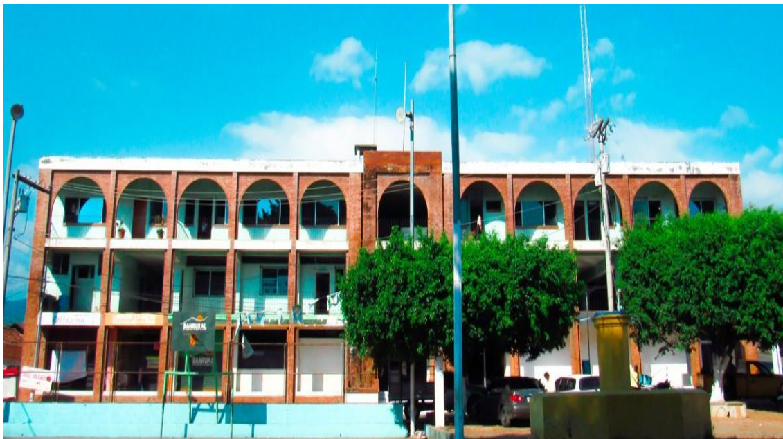
Fotografía 1 Actual edificio de la municipalidad de Taxisco, Santa Rosa
