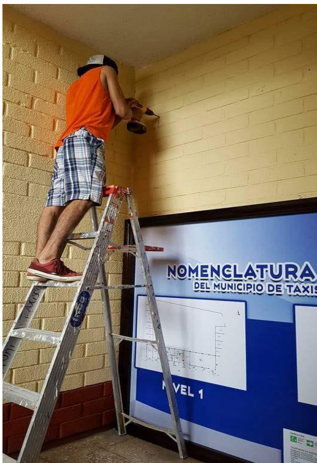
Fotografía 3 Instalación de nomenclatura del edificio municipalidad de Taxisco, Santa Rosa
