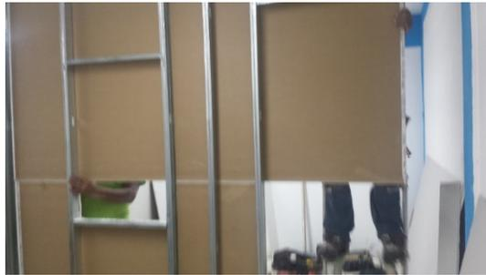
Imagen # 8 colocación del primer panel de tabla yeso para la pared.
