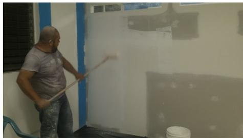
Imagen #10 enyesado de la parte trasera de la pared que se ha construido.
