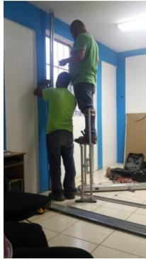
Imagen # 5 medición del alto que ocupará la pared construida durante el proyecto.
