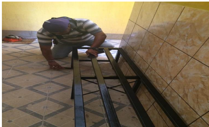
Figura 4.5 Colocación de banca de metal en área de lavamanos.
