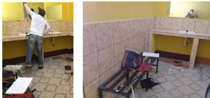
Figura 4.6 Colocación de 2 espejos, a un costado de la sala del E.P.S del área de lavamanos.
