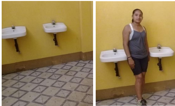
Figura 4.1 Estado inicial del espacio físico del área de lavamanos.
