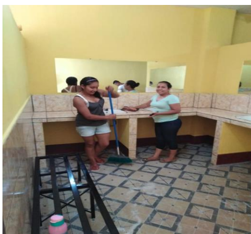
Figura 4.7 Limpieza del piso en área de lavamanos para hombres.
