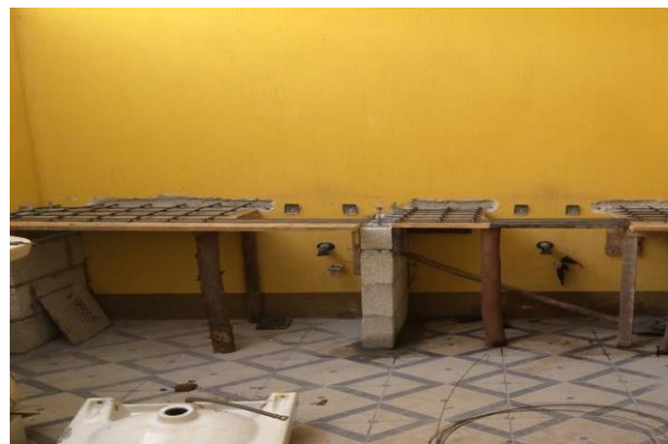
Figura 4.2 Construcción de base con bloques de tabique, para los lavamanos.
