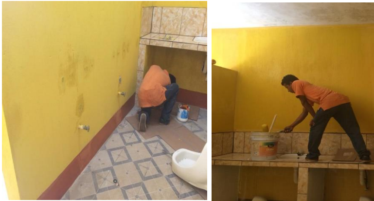
Figura 4.4 Pintando las paredes del espacio físico en el área de lavamanos para hombres.
