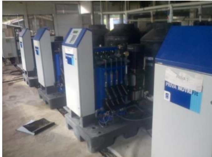
Figura 22. Maquina PRIVA Nutrifit reguladora de riego
