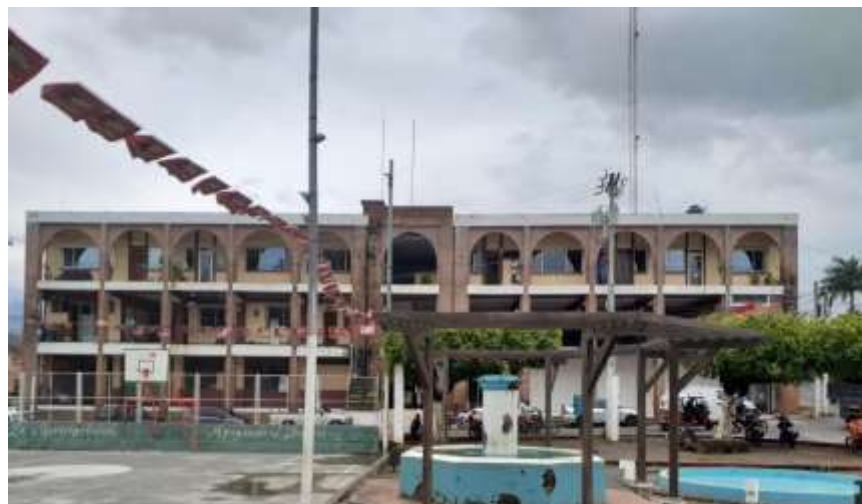
Figura No. 4: Actual edificio de la municipalidad de Taxisco, Santa Rosa
