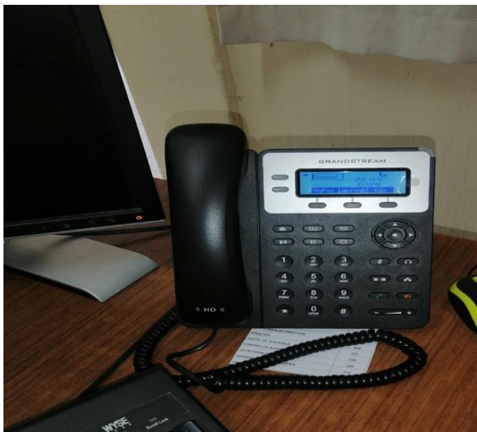
Fotografía No. 72 Trabajo de voluntariado finalizado, teléfono con un nuevo sistema de comunicación más eficiente. Fuente: Mariela Molina
