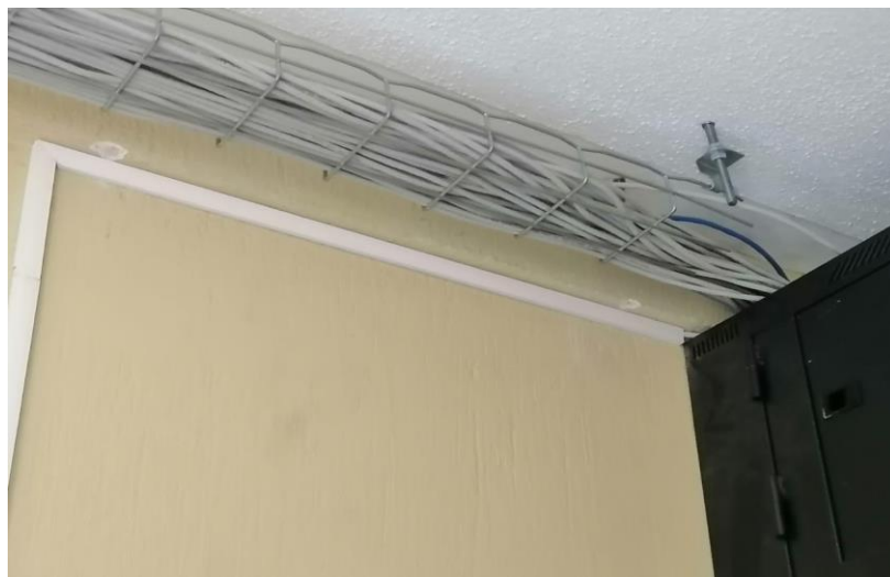
Fotografía No. 68 Instalación de UTP. Fuente: Mariela Molina
