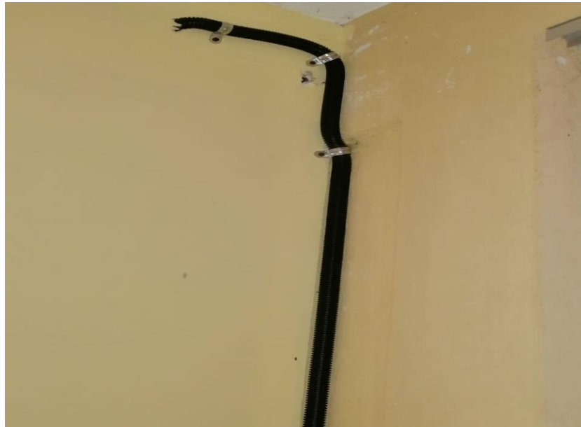
Fotografía No. 69 Instalación del material necesario para la ejecución del voluntariado.
