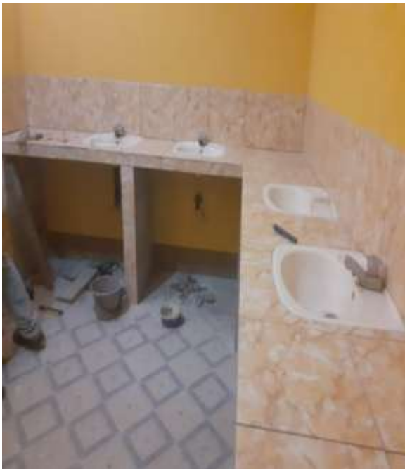
Figura 7. Colocación de azulejos.
