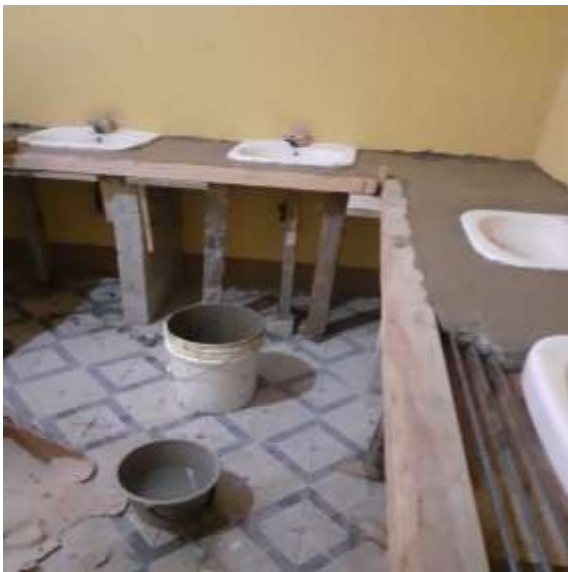
Figura 6. Fundición de parrilla
