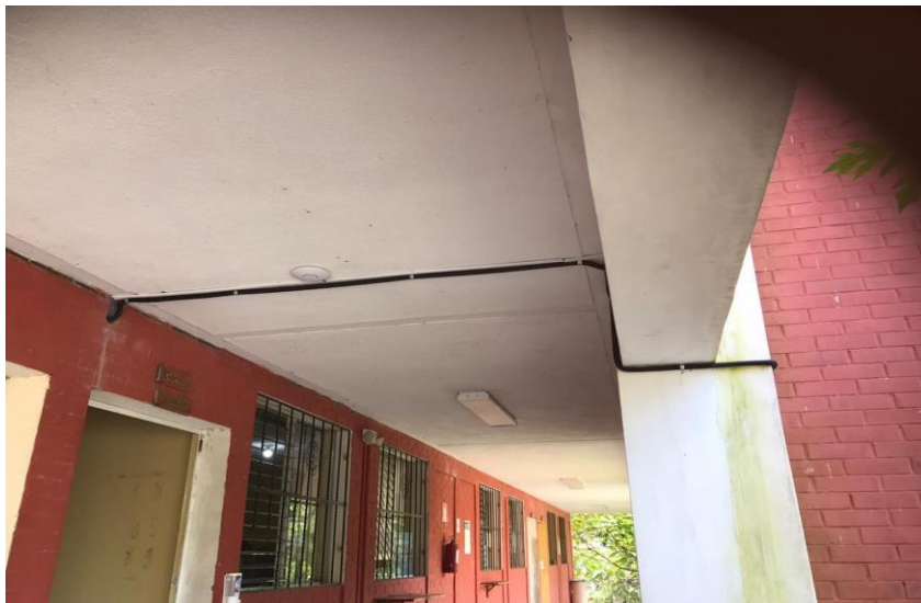
Fotografía No. 4 instalación de los servidores
