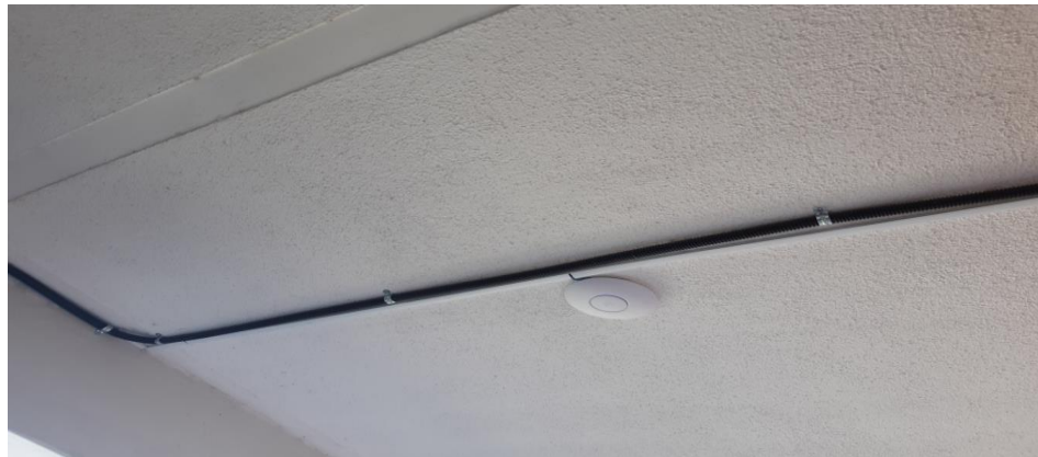
Fotografía No 11 /Instalación del cableado/
