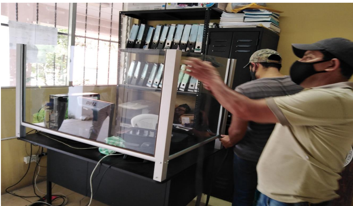
Fotografía 4 /Instalando la cortina de vidrio /Fuente: Keny Trigueros
