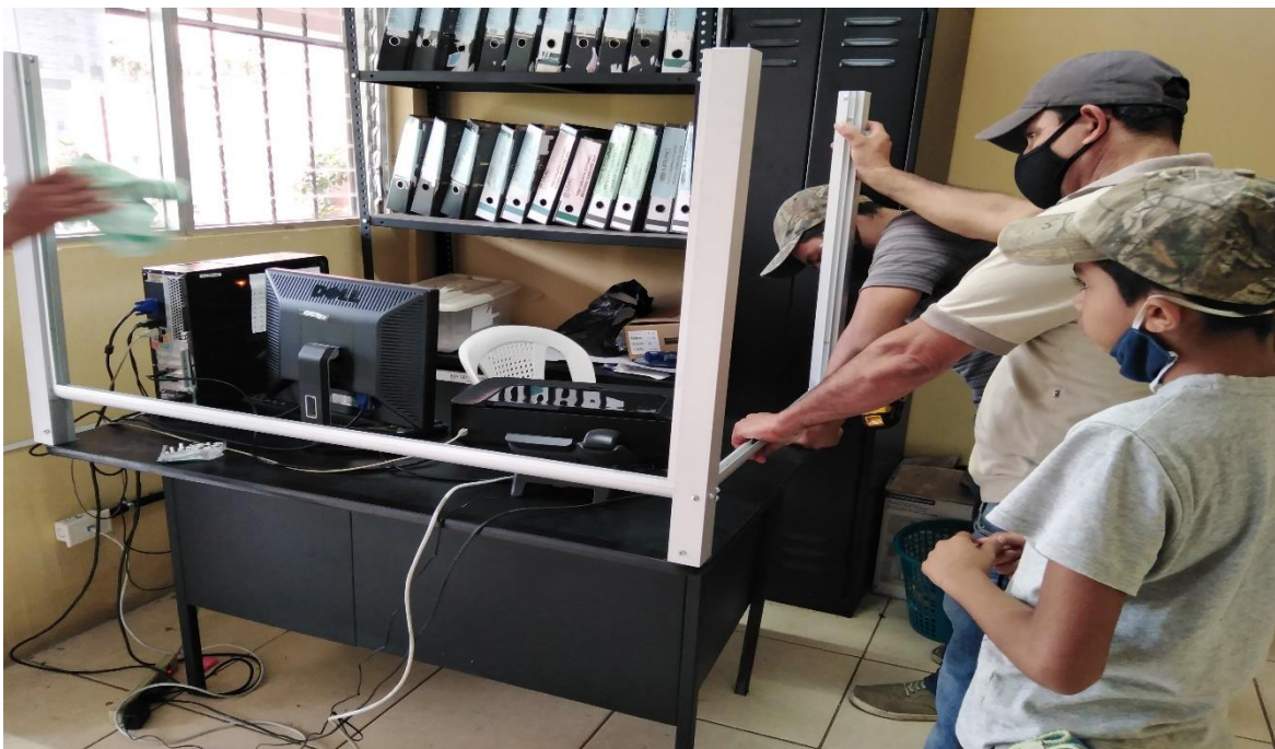
Fotografía 3 /Instalando la cortina de vidrio /Fuente: Keny Trigueros
