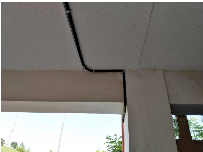
Fotografía 12/Durante la instalación de red /Fuente: Otoniel Hernández
