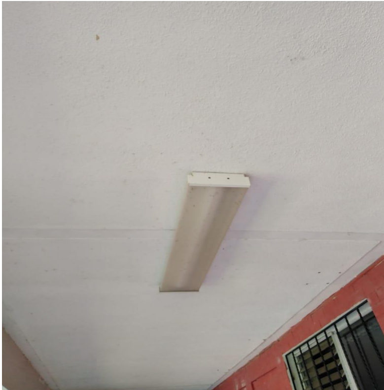
Fotografía 11/Antes de la instalación de red /Fuente: Otoniel Hernández
