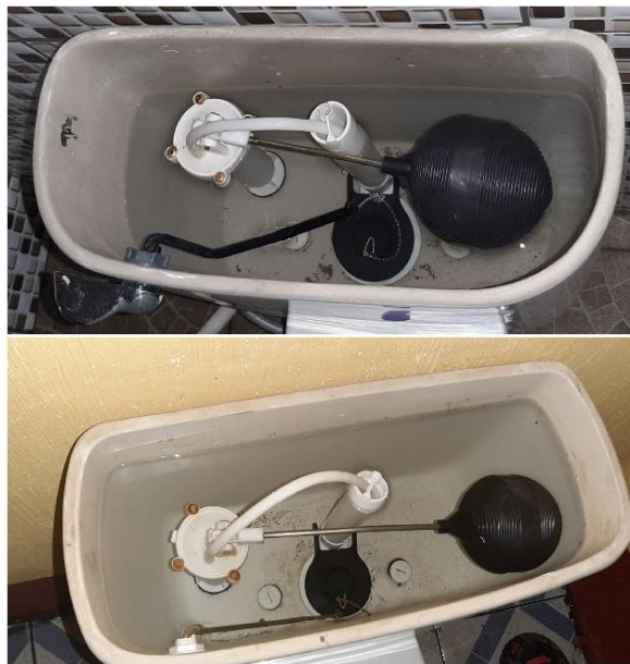
Figura 35 Tanques de los sanitarios restaurados.
