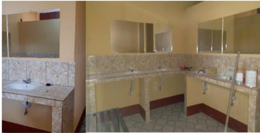
Figura 32 área de lavamanos de los sanitarios de mujeres.
