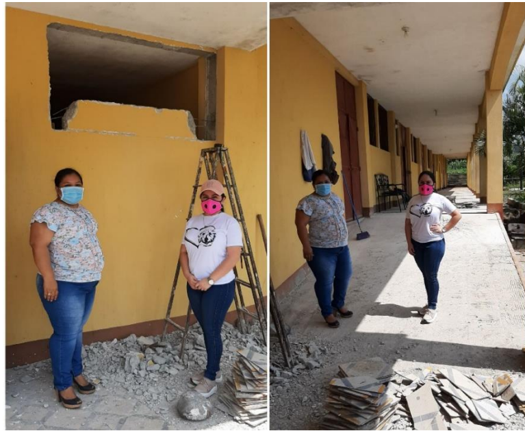
Figura 16 Observación del avance de la obra.
