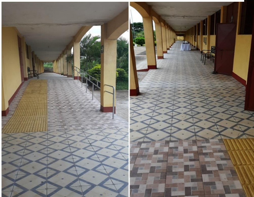
Figura 23 Remodelación del pasillo.
