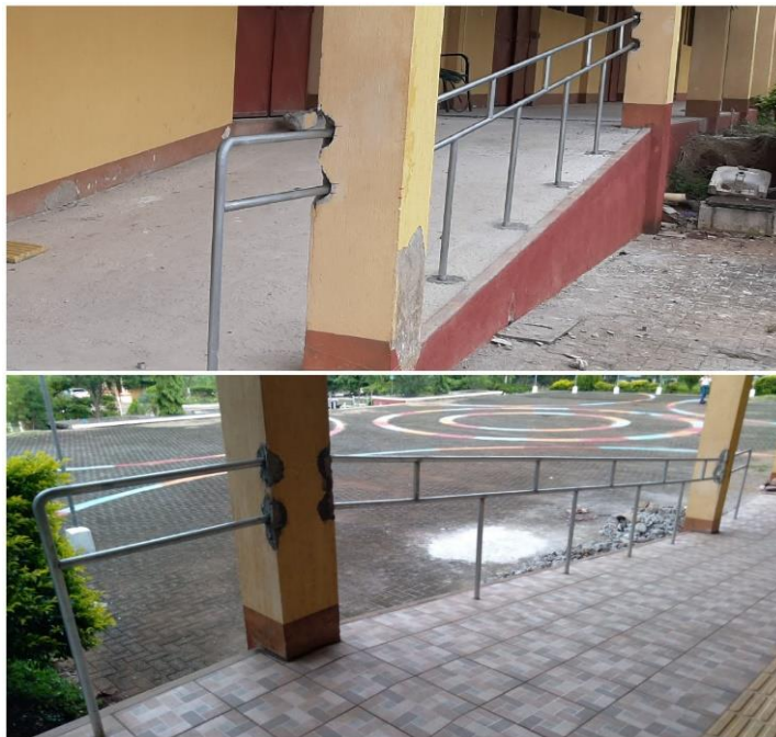
Figura 17 Instalación de pasamano.
