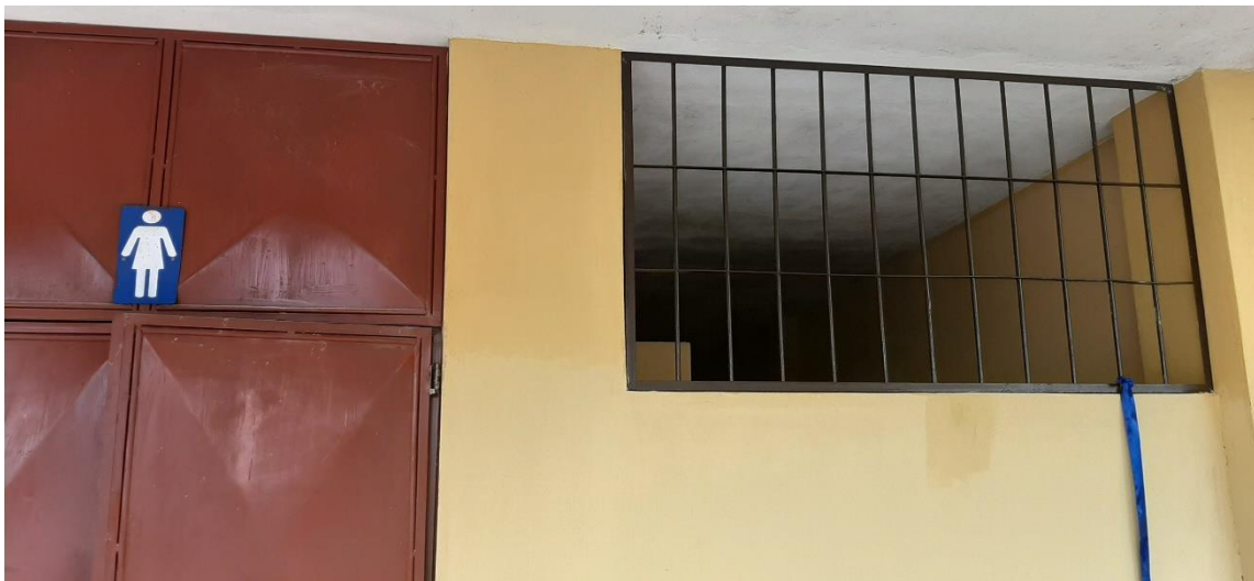
Figura 26 Construcción de ventana.
