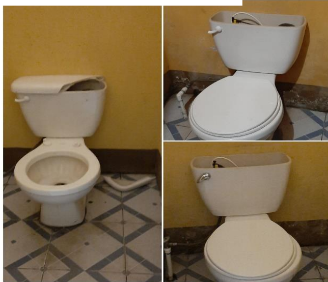
Figura 30 Tapaderas de depósitos de sanitario.
