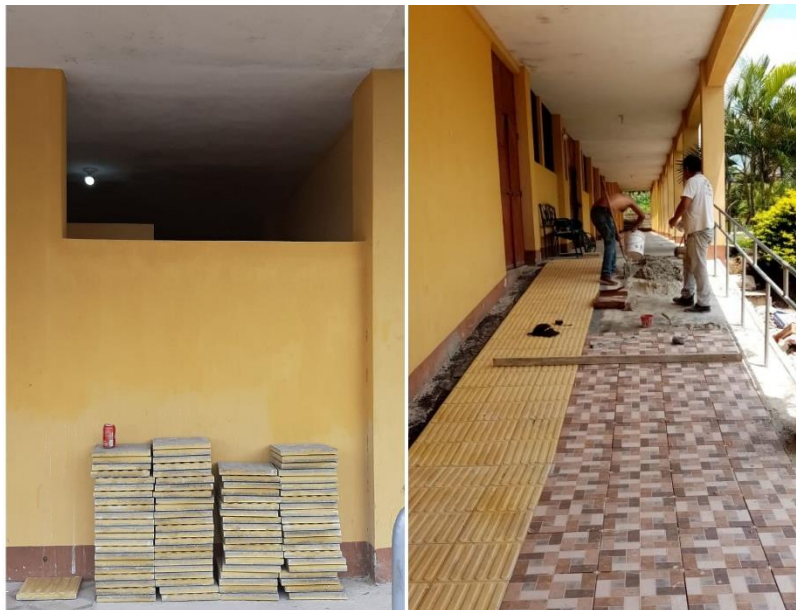
Figura 19 Colocación de ventana y el piso.
