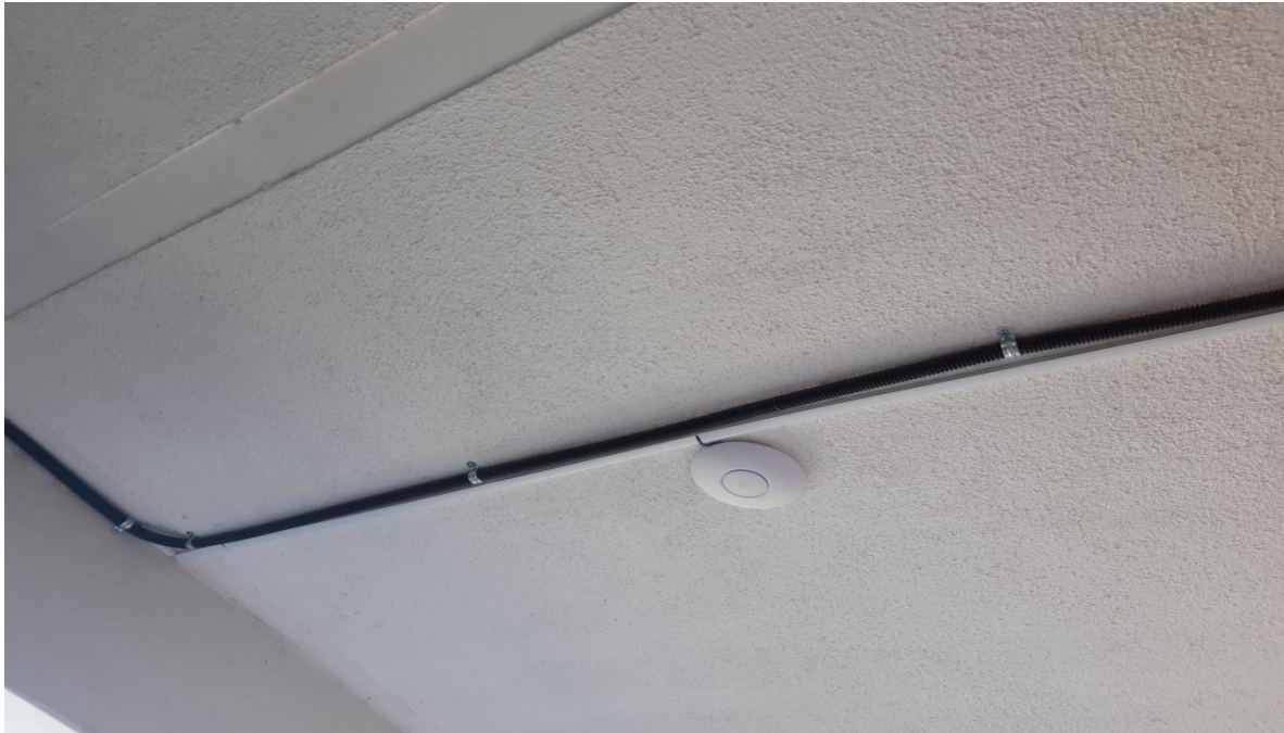
Fotografía 10 /Instalación del cableado/Fuente: Shirley Zepeda
