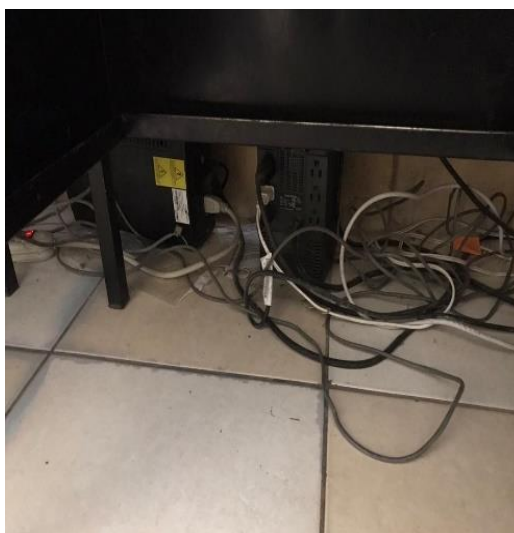
Fotografía No. 64/ Instalación de cables UTP para la aplicación redes inalámbricas. / Fuente: Cristian Véliz.
