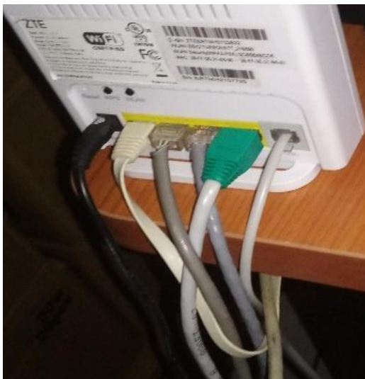
Fotografía No. 63/ Instalación cables conectores RJ45 / Fuente: Cristian Véliz.
