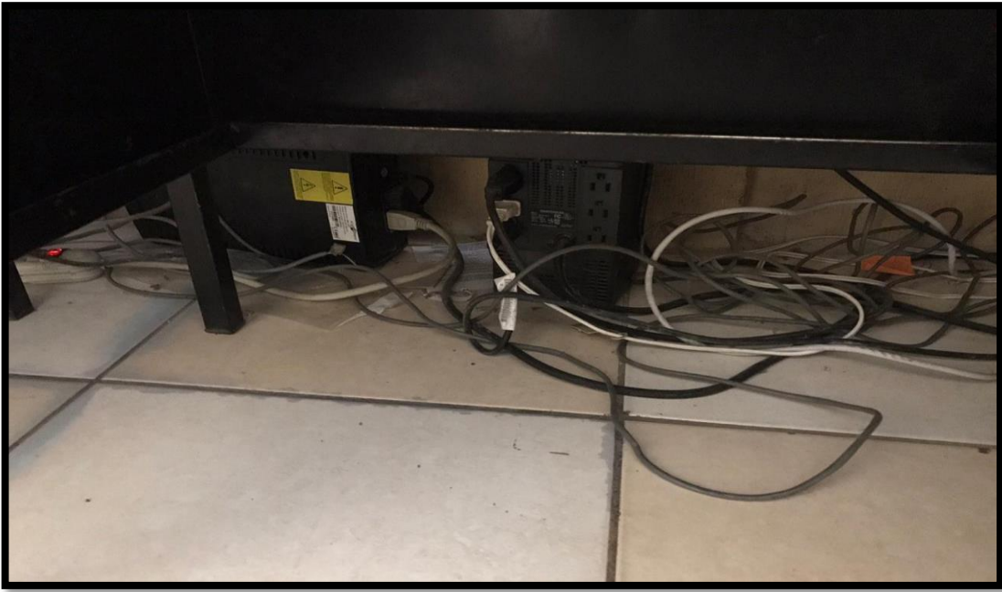
Fotografía No. 53. Instalación de cables UTP correspondiente a la red inalámbrica de telefonía Fuente: Leidy Celeste Hernández González Estudiante ejecutora.
