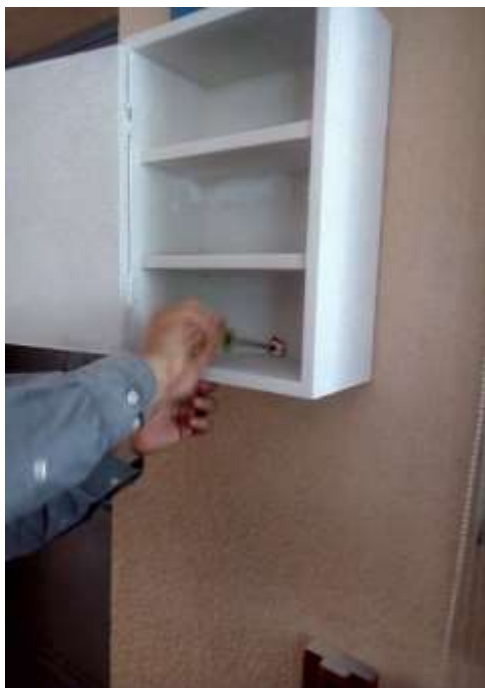
Figura 8 Durante la instalación del botiquín segundo nivel.
