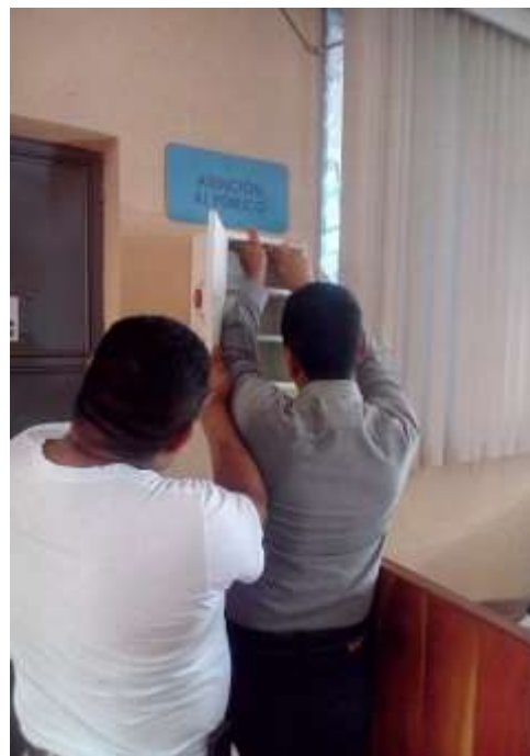
Figura 7 Durante la instalación del botiquín Instalación primer nivel.
