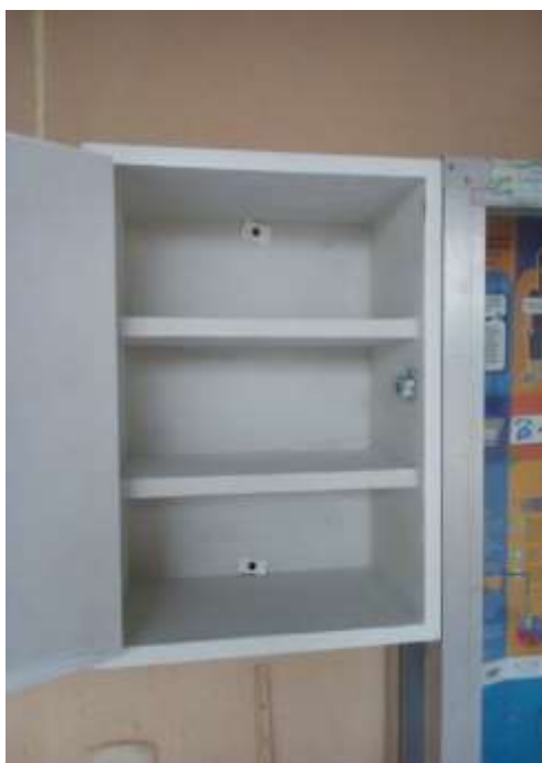
Figura 10 Después de la instalación del botiquín segundo nivel
