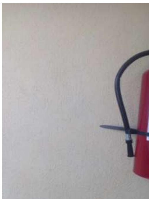
Figura 4 Antes de la instalación del botiquín Instalación primer nivel.
