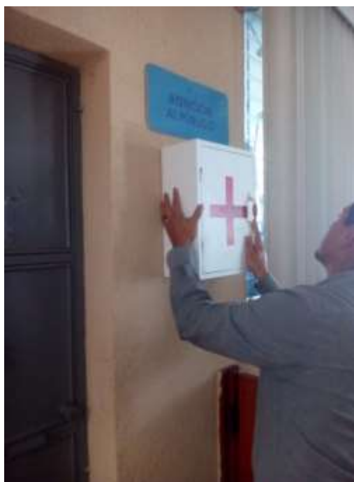
Figura 6 Durante la instalación del botiquín Instalación primer nivel.
