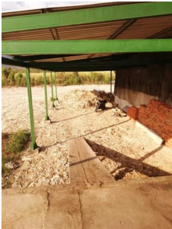
Figura 8. Almacén de bagazo o bagacera
