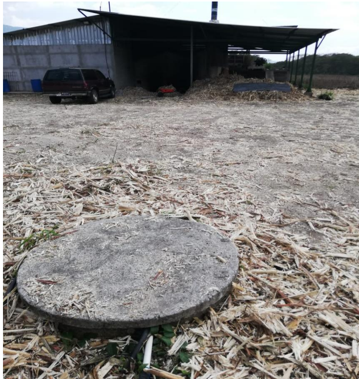
Figura 3. Tanque artesanal para agua potable
