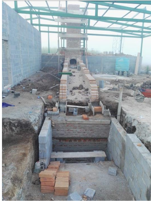
Figura 23. Construcción de ductos y colocación de esclusa, al fondo entrada del flujo de aire caliente a chimenea.
