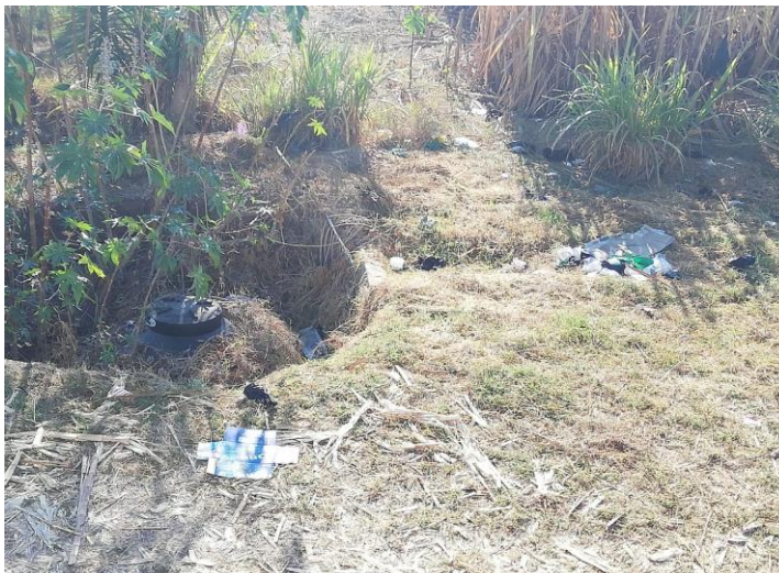
Figura 10. Planta de tratamiento de aguas residuales
