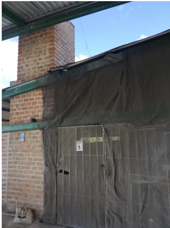
Figura 16. Malla cubriendo el área de producción.
