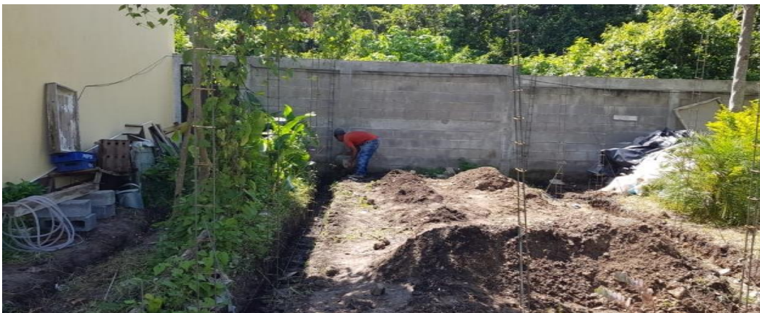
Anexo 13. Fundición de base para el cemento.
