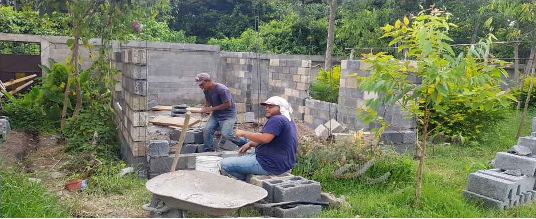
Anexo 14. Levantado de paredes.
