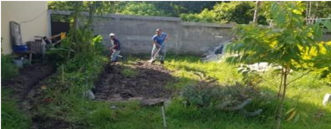
Anexo 12. Trazo y zanqueo del perímetro del área para el módulo de producción de hongo.
