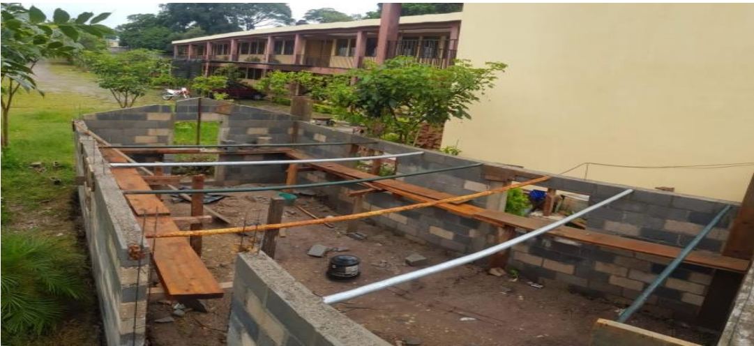
Anexo 15. Instalación de transversales para soporte del hongo.
