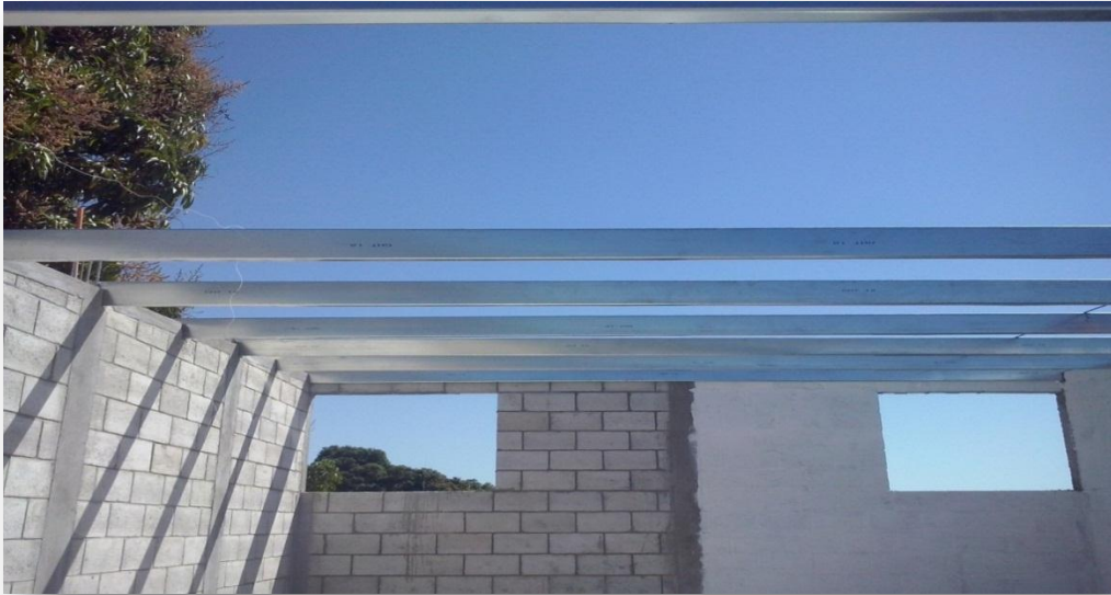
Figura 12. La fotografía muestra la colocación de estructura metálica.
