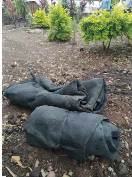
Imagen No. 13 “Instalación de sarán”
