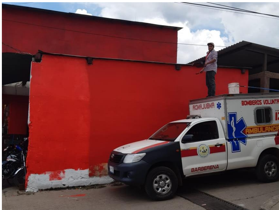
Fotografía 7. Proceso de pintura de paredes
