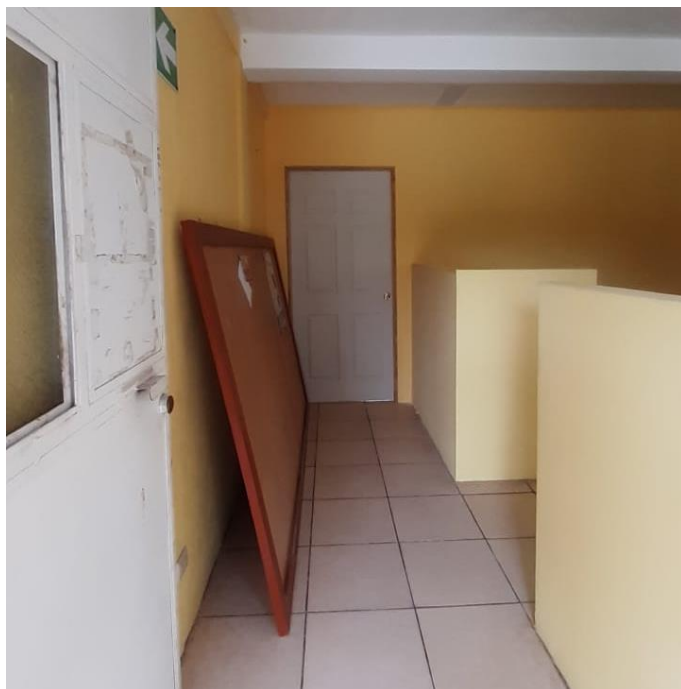
Fotografía 16. Puerta de oficina instalada
