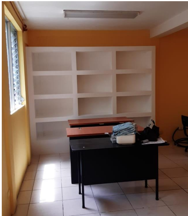
Fotografía 15. Archivo de tabla yeso terminado
