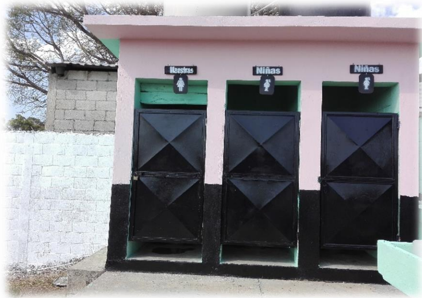
Fotografía 31/ Remozamiento de Sanitarios para niñas
