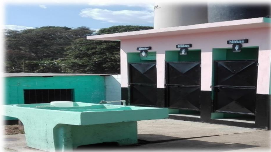
Fotografía 32/ Remozamiento de sanitarios para niñas
