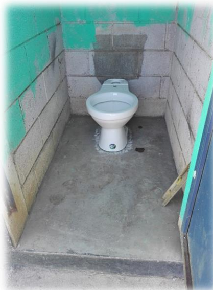
Fotografía 30/Colocación de Sanitarios Nuevos
