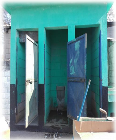
Fotografía 29/Retiro de sanitarios
