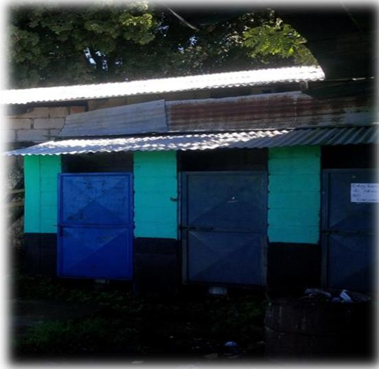
Fotografía 18/ Deterioro de pintura en sanitarios
