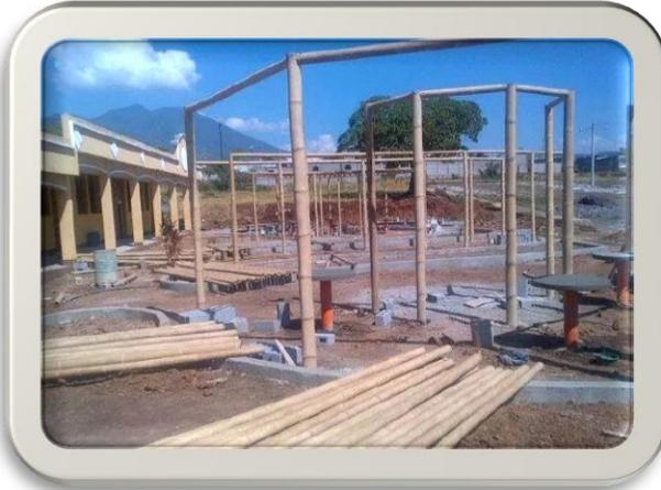
Limpieza del bambú y colocación de las bases
