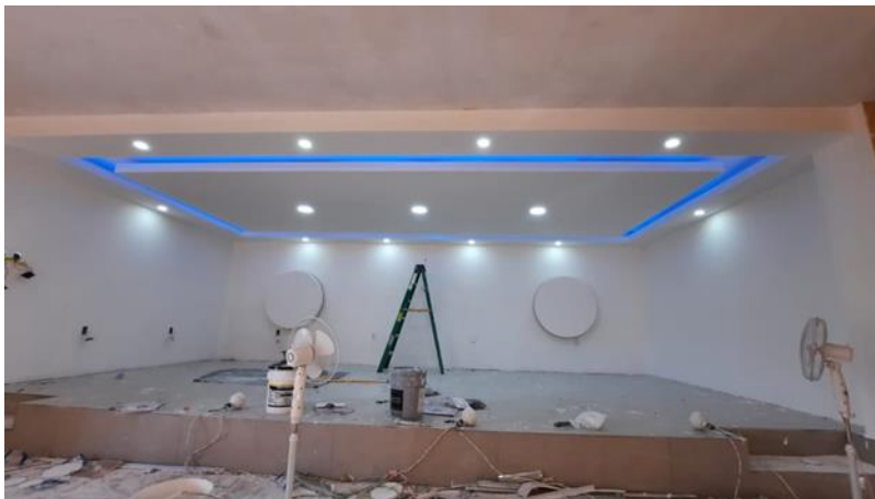
Figura 10 Colocación de rótulos luminosos
