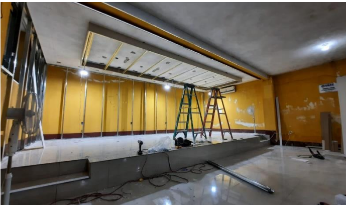
Figura 8 Entrega de los materiales para la ejecución del remozamiento
