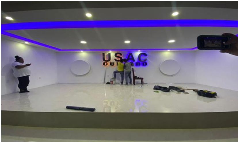
Figura 9 Proceso de remodelación del escenario
