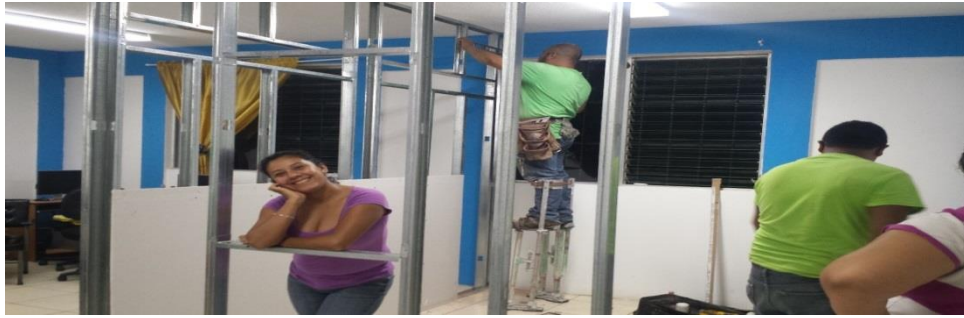
Foto 3: Construcción del módulo con mobiliario y equipo tecnológico, para uso de la coordinación de la carrera de Pedagogía, sección Cuilapa
