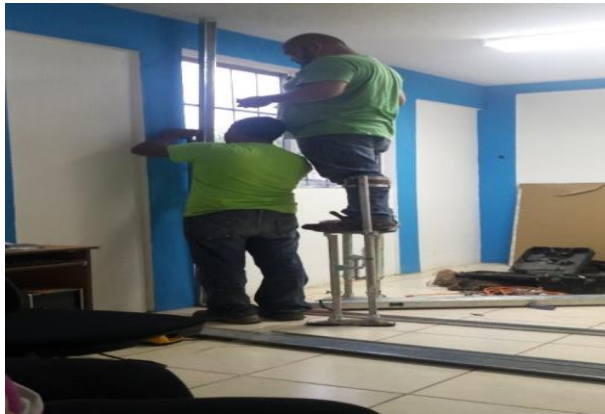
Foto 1: Construcción del módulo con mobiliario y equipo tecnológico, para uso de la coordinación de la carrera de Pedagogía, sección Cuilapa.
