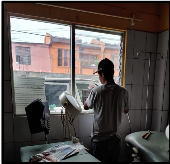
Ilustración 21 Instalación de Paletas
