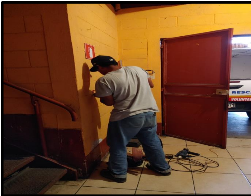
Ilustración 4 Colocación de extintor
