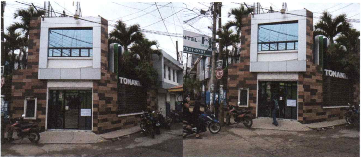
Figura 2. Instalaciones de Agencia Central Cooperativa Tonantel R.L.
