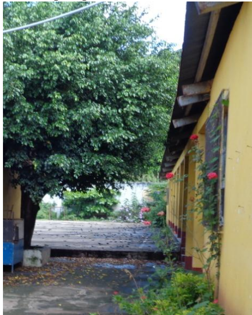
Figura 15. Antes de limpiar para el remozamiento
