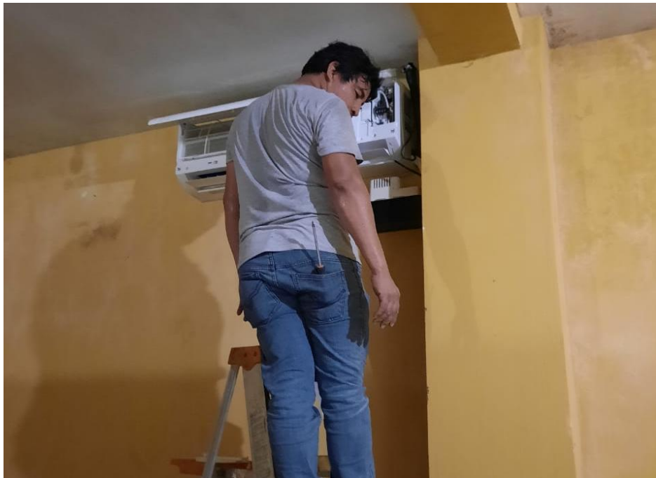
Figura 11. Proceso de instalación del equipo de aire por terminarse.
