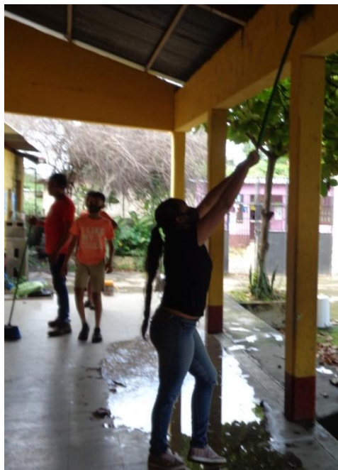
Figura 16. Inicia limpieza para remozamiento de escuela.
