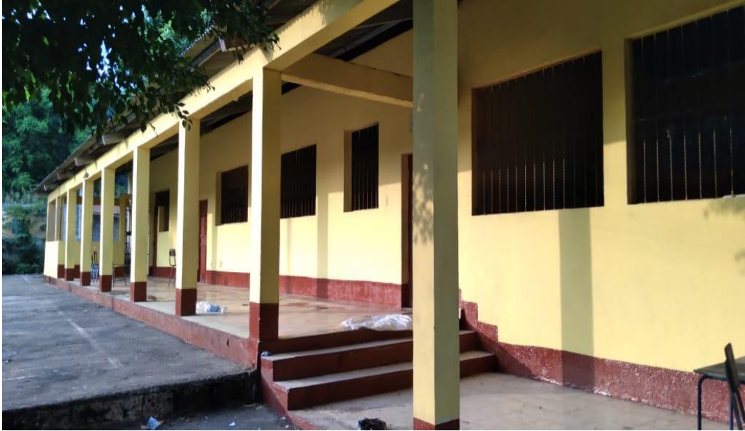
Figura 14. Estado inicial de la escuela antes del remozamiento
