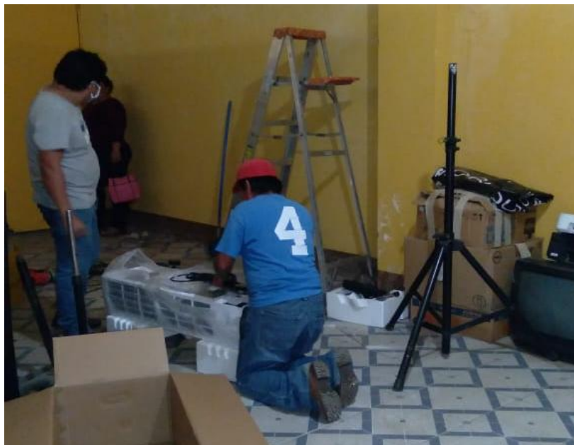
Figura 9. Iniciando la instalación
