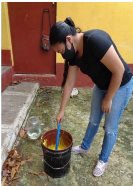
Figura 17. Preparación de la pintura para el remozamiento.
